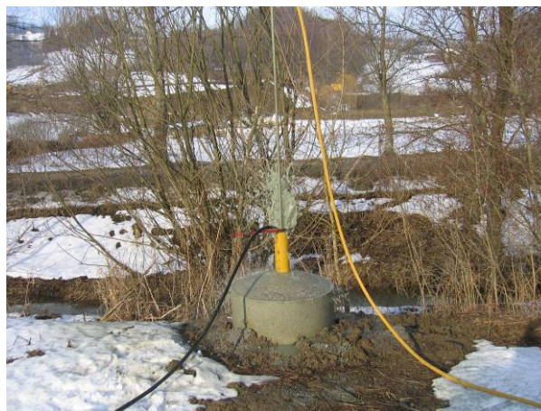
Slika 2.5.1.4.1.: Vrtina MEP-4 med čiščenjem
