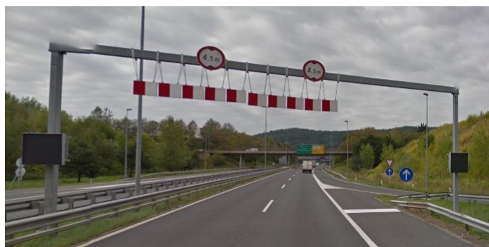
Slika 18: Primer SPIS-OCT v podсистemu višinske kontrole
