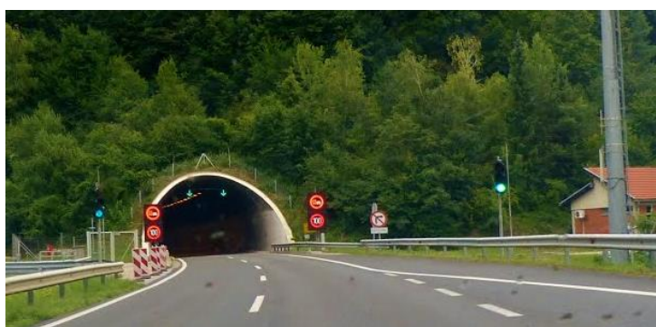
Slika 19: Primer dvojnega SPIS-OCT v podсистemu vodenja prometa pred predorom
