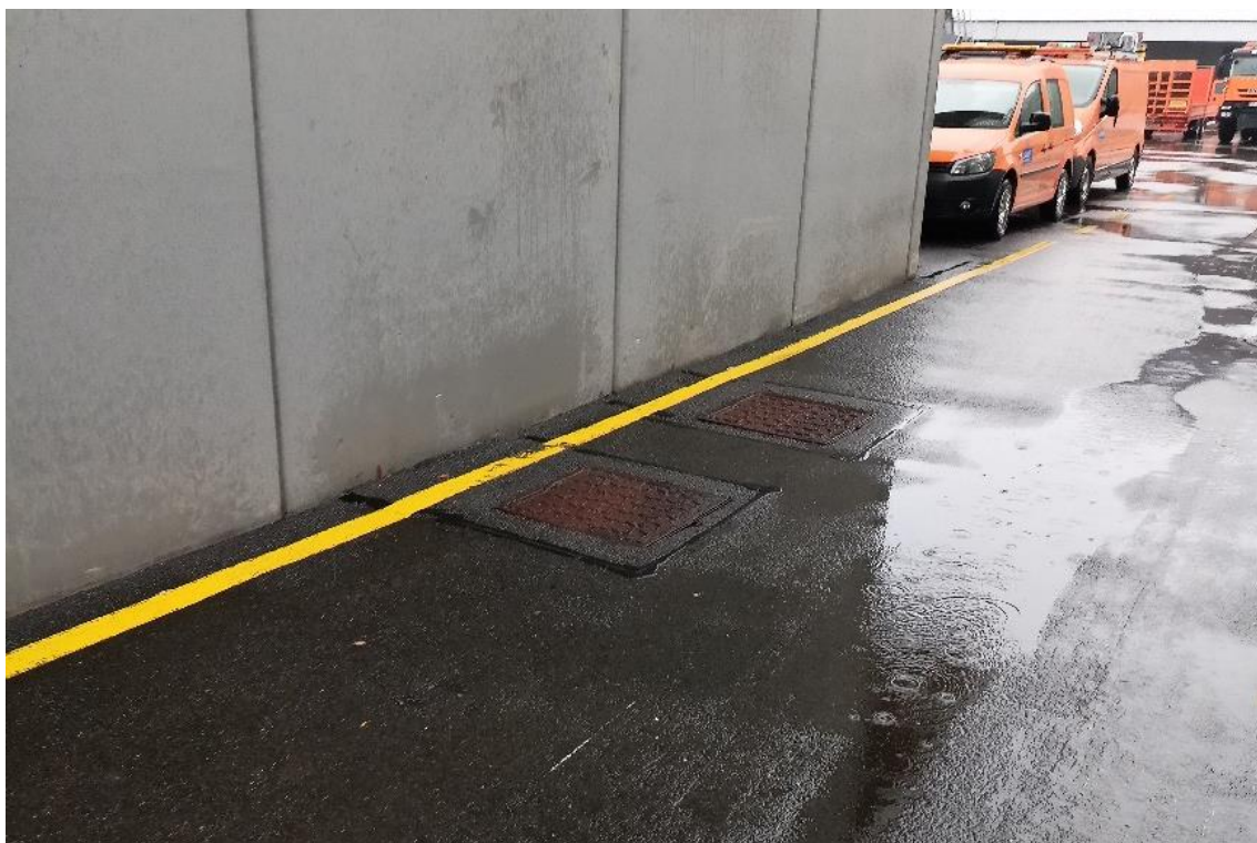
Slika 4: Jašek J2, dvojni pokrov (Vir: lastni)
