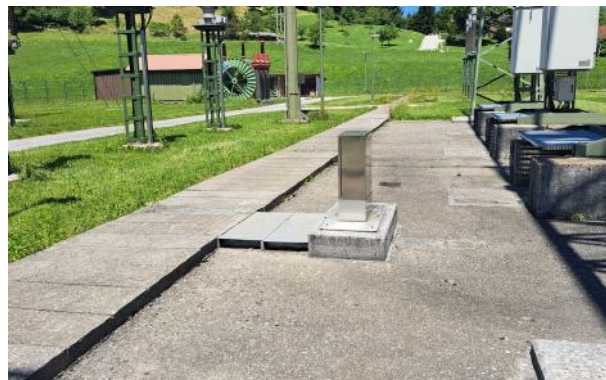
Slika 9: Servisne poti in ploščadi pod odklopniki
