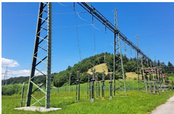
Slika 6: Jeklene konstrukcije portalov in glave čašastih temeljev
