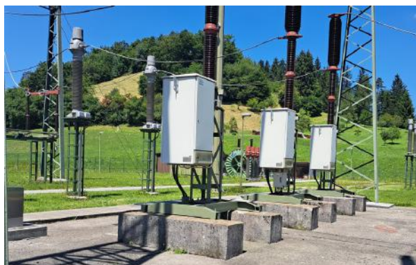
Slika 7: Jeklene konstrukcije podstavkov VN aparatov, glave čašastih temeljev in pasovni temelji podstavkov odklopnikov
