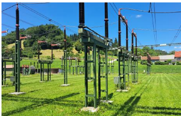
Slika 7: Jeklene konstrukcije podstavkov VN aparatov, glave čašastih temeljev in pasovni temelji podstavkov odklopnikov
