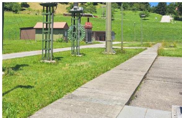
Slika 8: Zbirni armiranobetonski kabelski kanali v 220 kV stikališču
