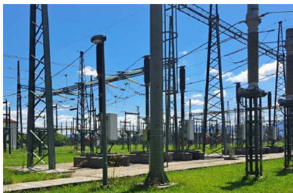
Slika 6: Jeklene konstrukcije portalov in glave čašastih temeljev
