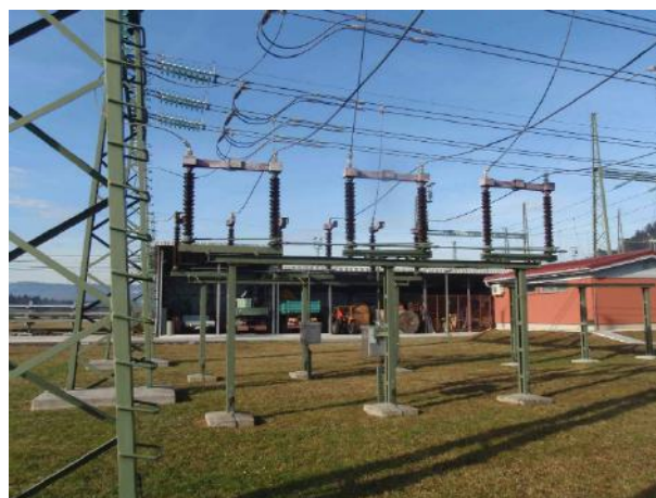
Slika 13: Konstrukcije, VN oprema in ureditev v 110 kV stikališču
