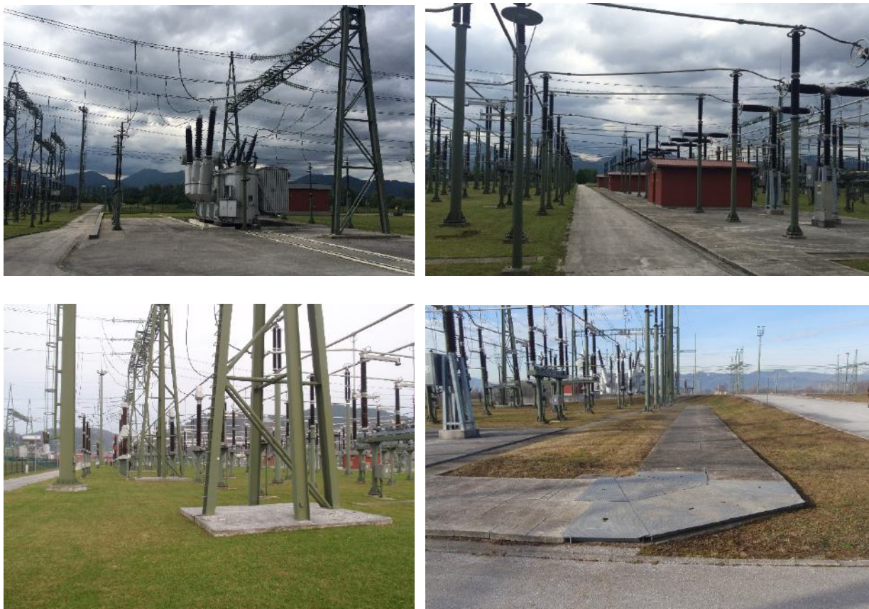
Slika 5: Konstrukcije, VN oprema in ureditev v 400 kV stikališču
