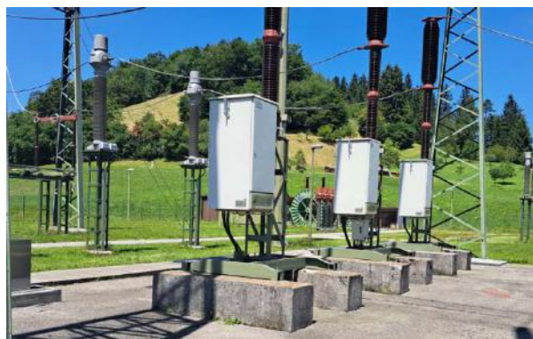
Slika 2: Jeklene konstrukcije podstavkov VN aparatov, glave čašastih temeljev in pasovni temelji podstavkov odklopnikov
