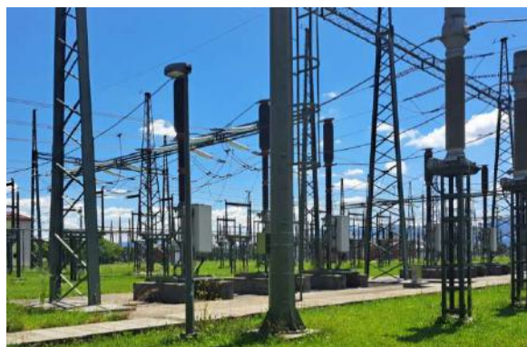
Slika 1: Jeklene konstrukcije portalov in glave čašastih temeljev
