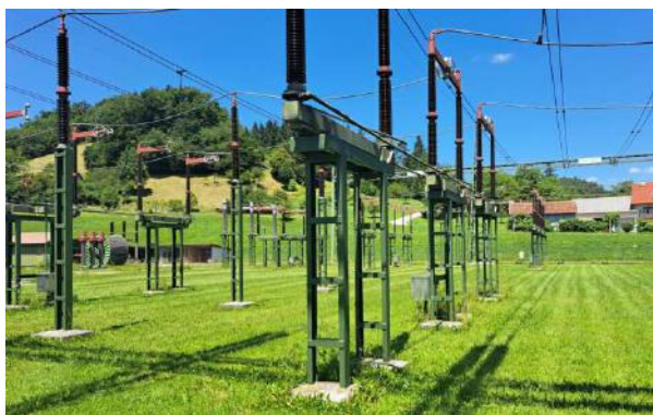
Slika 2: Jeklene konstrukcije podstavkov VN aparatov, glave čašastih temeljev in pasovni temelji podstavkov odklopnikov
