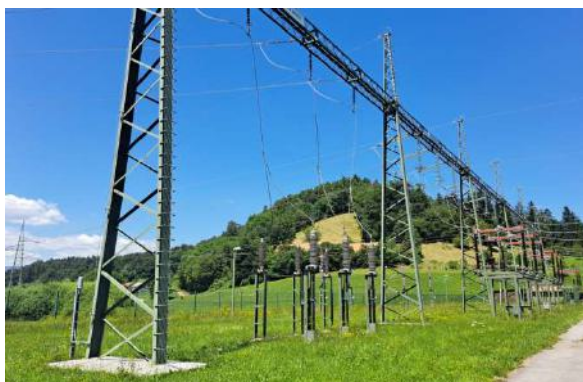
Slika 1: Jeklene konstrukcije portalov in glave čašastih temeljev
