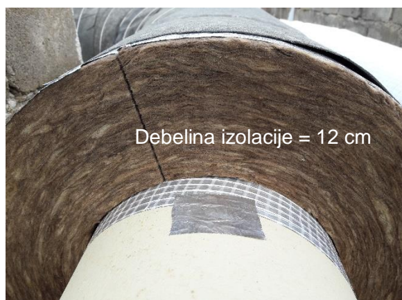
Slika 9 LEVO: Stanje izolacije pred sanacijo; DESNO: Nov izolacijski sloj cevovoda
