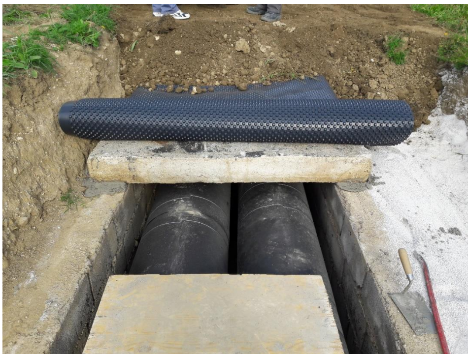
Slika 10: Pokrivanje kinete s krovnimi ploščami
