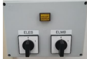
Slika 4-1: Primer izbirne preklopke pri vstopu v GIS stikališče
