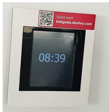
Slika 35: Sistem za regulacijo temperature po posameznih prostorih – le deloma vgrajeno v nekaterih prostorih Vojkova 1b.
