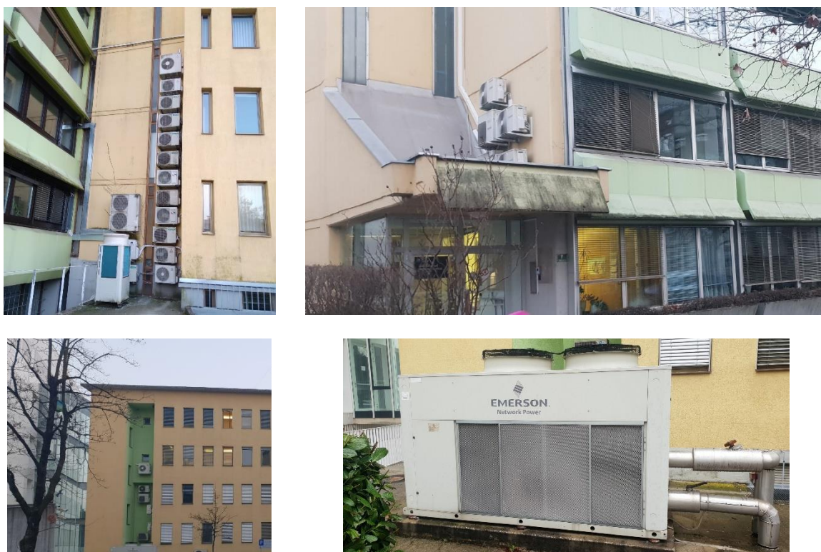
Slika 32: Split hladilne naprave in hladilni agregat za hlajenje superračunalnika (spodaj desno).
