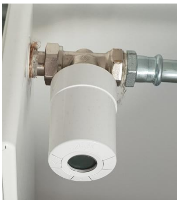
Slika 29: Sistem za regulacijo temperature po posameznih prostorih – le deloma vgrajeno v nekaterih prostorih Vojkova 1b.
