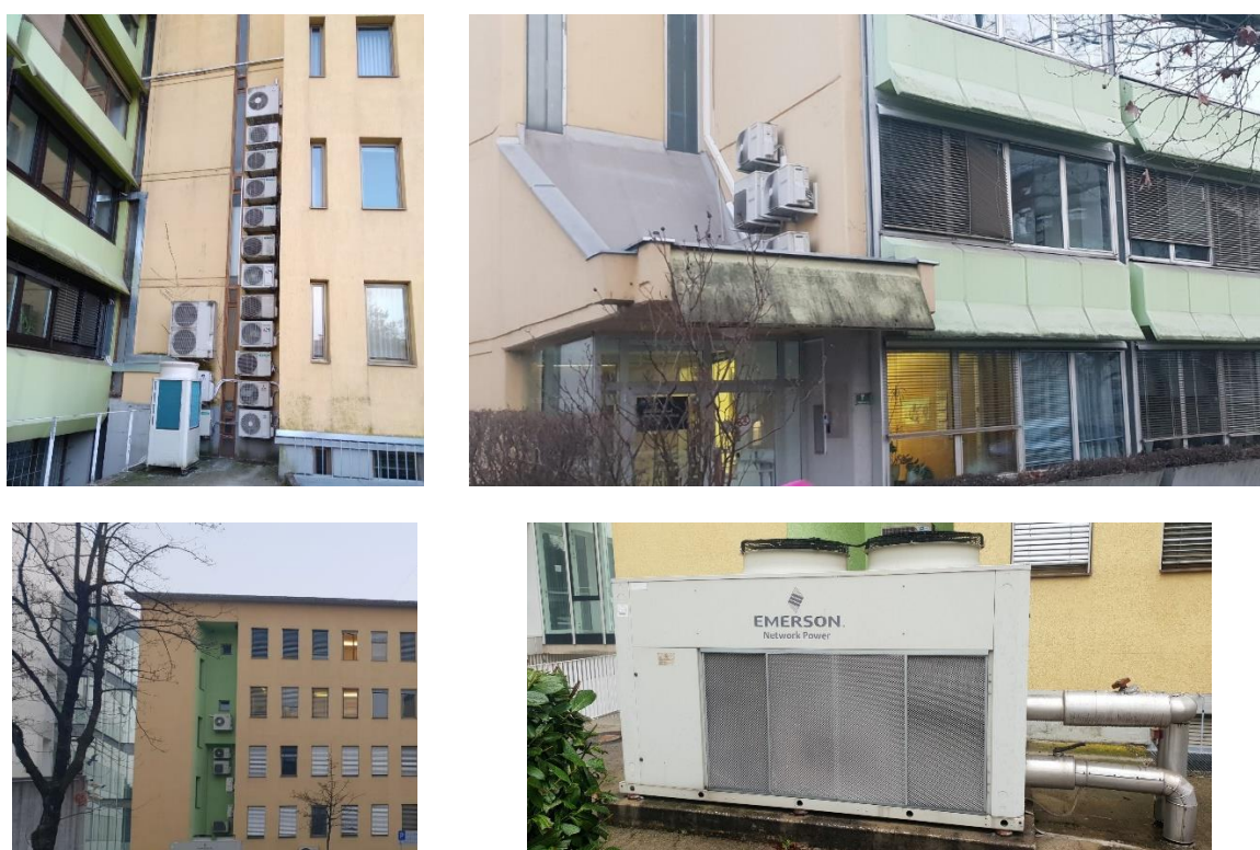
Slika 26: Split hladilne naprave in hladilni agregat za hlajenje superračunalnika (spodaj desno).
