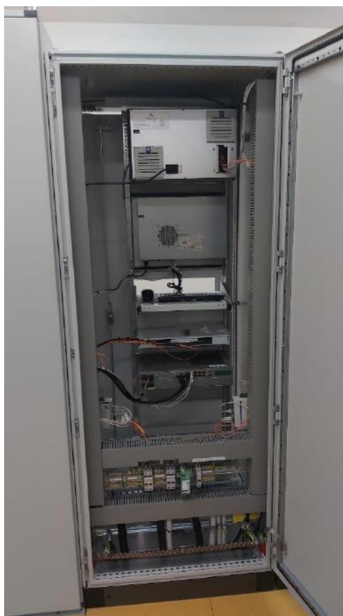
Slika 2: obstoječa serverska omara sistema sprotnega nadzora transformatorja
