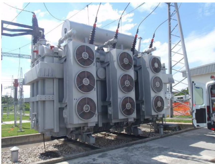
Slika 7: energetski transformator 220/110 kV - T211
