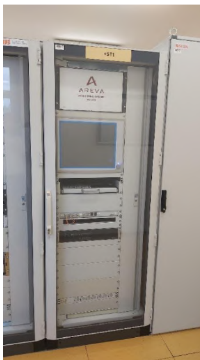
Slika 1: obstoječa serverska omara sistema sprotnega nadzora transformatorja
