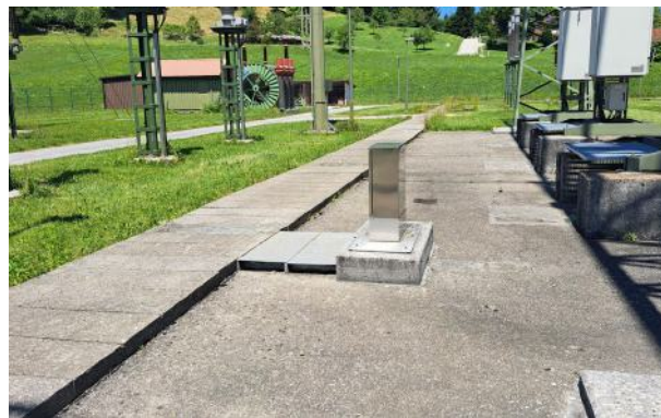
Slika 11: Servisne poti in ploščadi pod odklopniki
