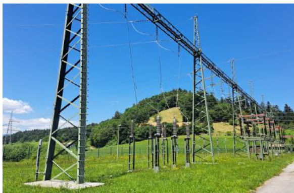
Slika 8: Jeklene konstrukcije portalov in glave čašastih temeljev
