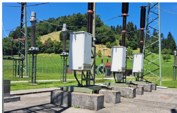
Slika 9: Jeklene konstrukcije podstavkov VN aparatov, glave čašastih temeljev in pasovni temelji podstavkov odklopnikov
