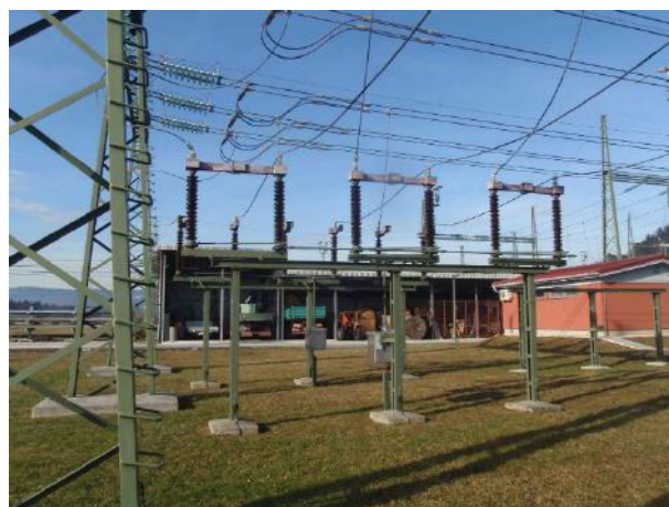
Slika 15: Konstrukcije, VN oprema in ureditev v 110 kV stikališču
