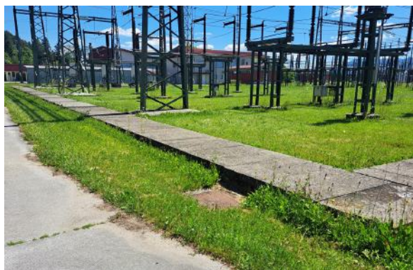
Slika 10: Zbirni armiranobetonski kabelski kanali v 220 kV stikališču
