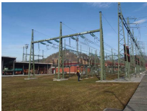
Slika 15: Konstrukcije, VN oprema in ureditev v 110 kV stikališču
