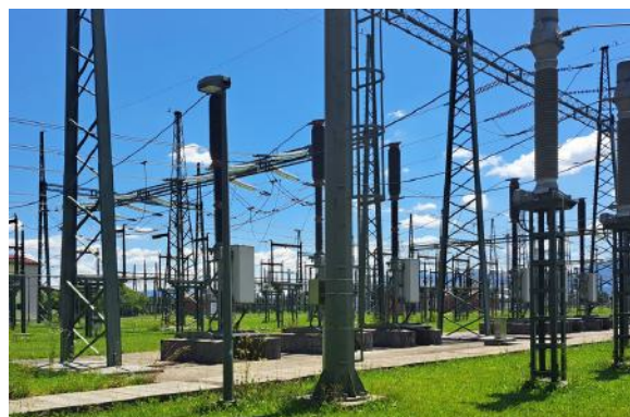
Slika 8: Jeklene konstrukcije portalov in glave čašastih temeljev
