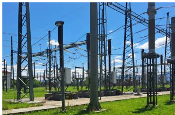
Slika 1: Jeklene konstrukcije portalov in glave čašastih temeljev
