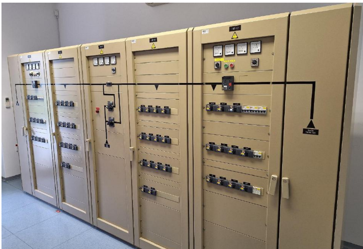
Slika 7: Izgled razdelilnika NE/NF, omare so brez vrat, krmilne ročice odklopnikov so dostopne skozi tipske sprednje pokrivne plošče
