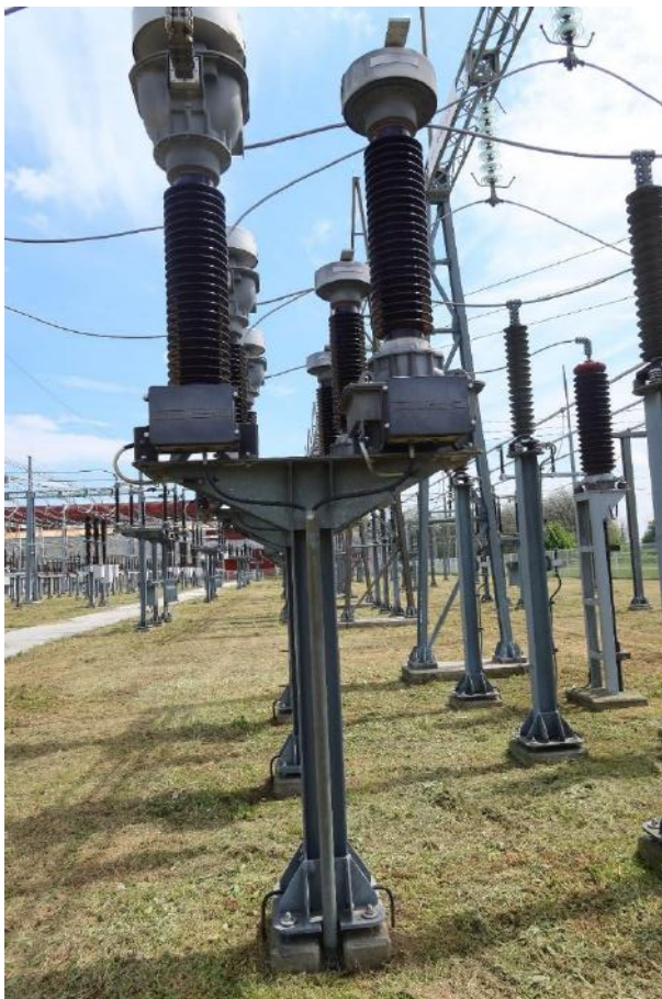
Slika 5: NMT in TMT na istem jeklenem podstavku
