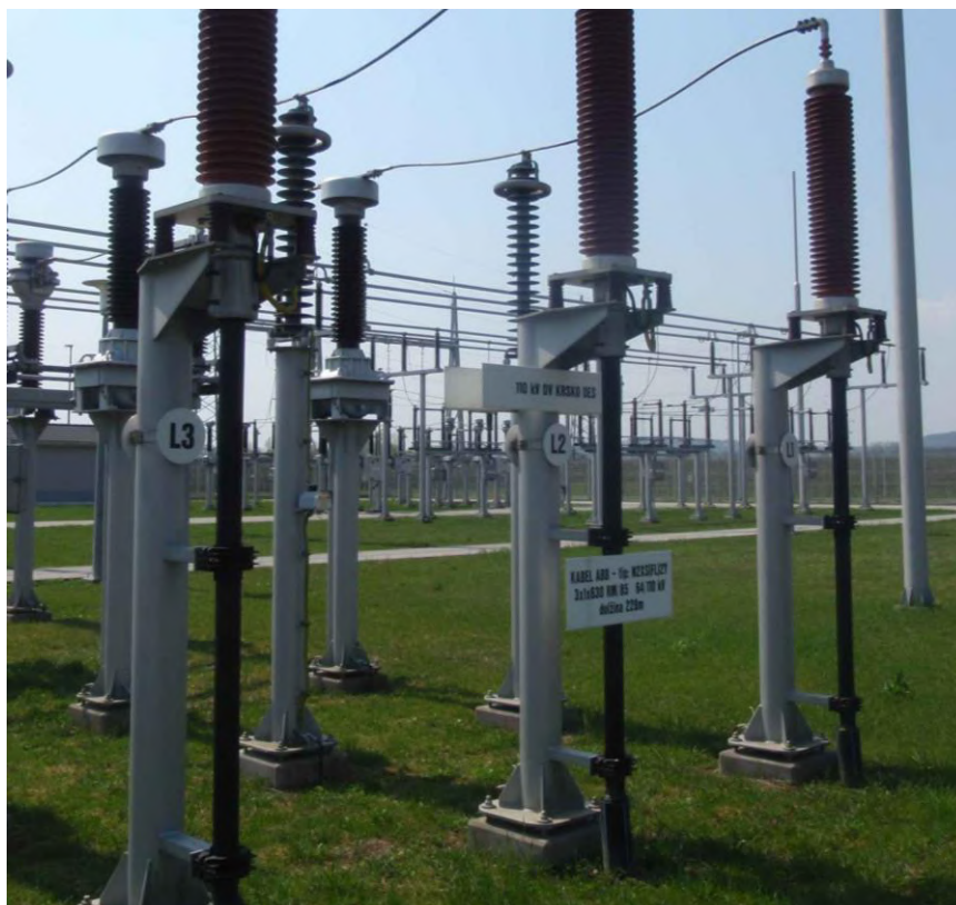
Slika 10: primer namestitve napisnih tablic za oznako faz 110 kV kablov
