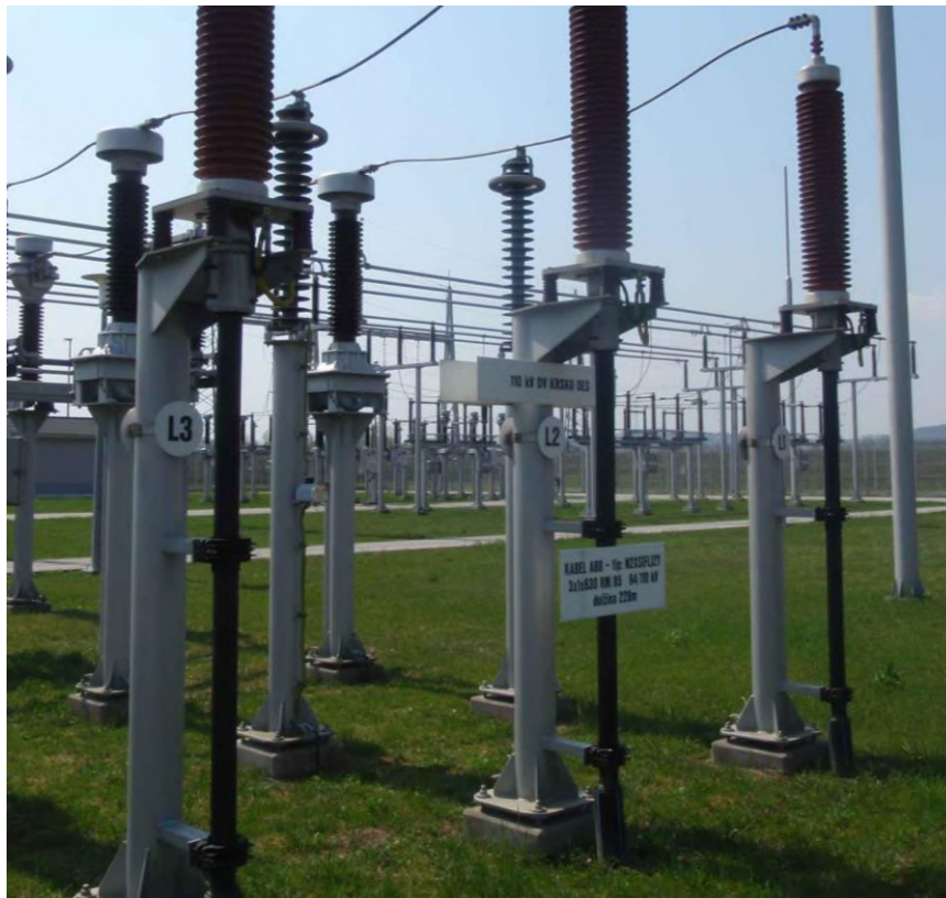
Slika 13: primer namestitve napisnih tablic za oznako faz 110 kV kablov
