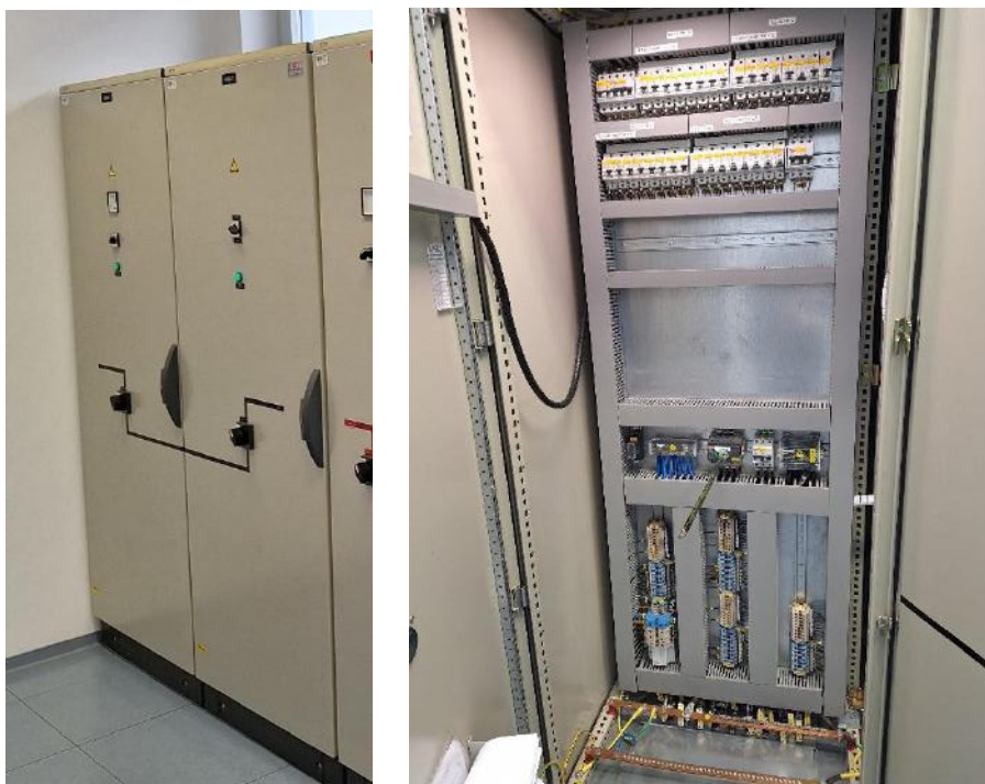
Slika 8: Izgled omar razdelilnika DB...1, DB...2 v relejni hiški (levo) in notranjosti (desno) ene od njih z dovodnim stikalom s podaljšano osjo ročice, krmilne ročice stikal so na vratih omare
