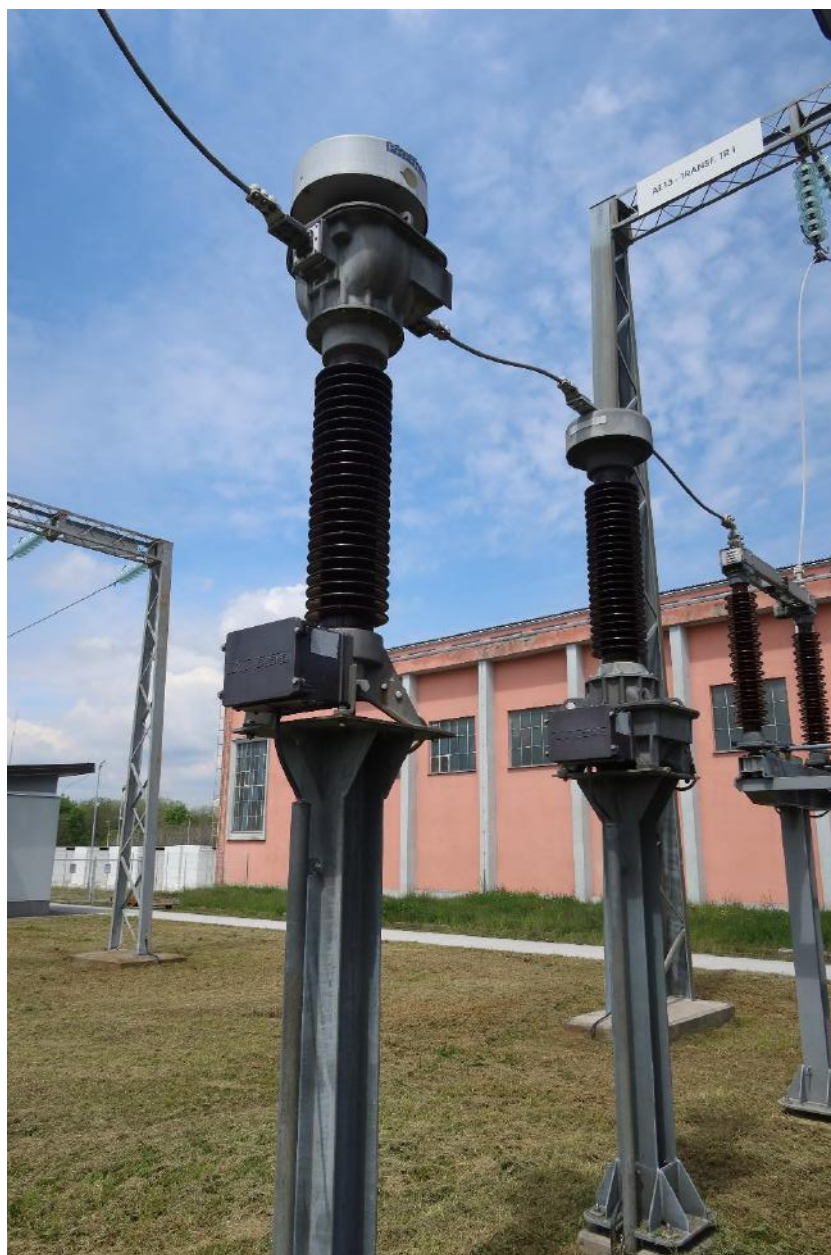
Slika 6: NIT in TIT na ločenih podstavkih
