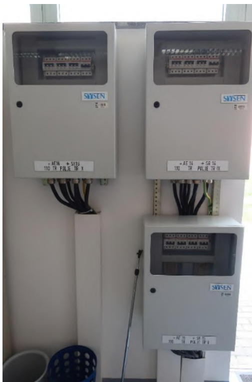
Slika 4: +SRxx omarice postavljene na steno v relejni hišici
