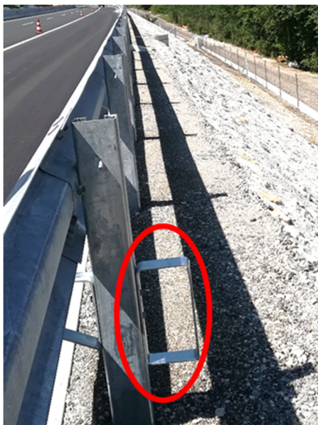
Slika 2: Stopa za prehod čez jekleno varnostno ograjo
