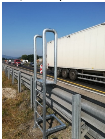
Slika 3: Lestev za prehod čez jekleno varnostno ograjo
