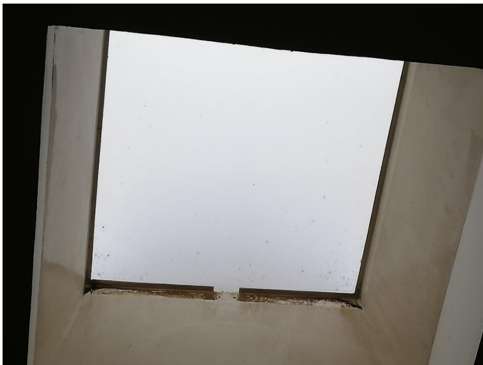
Slika 88: Prikaz dotrajane svetlobne kupole
