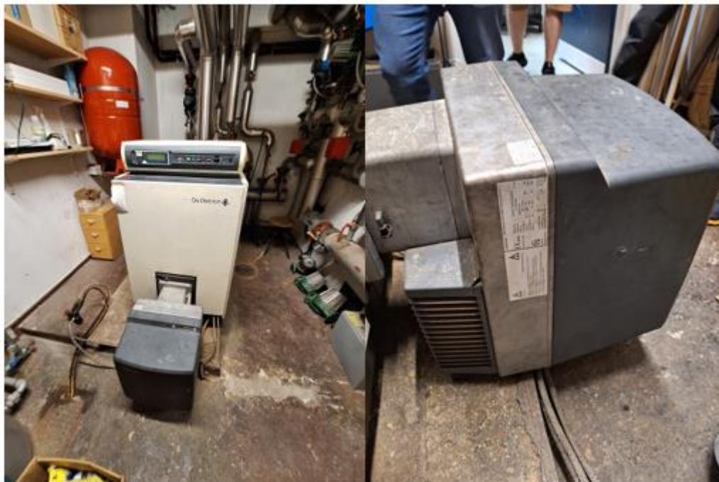
Slika 10: Levo, Kotel De Dietrich in desno, oljni gorilnik Weishaupt
