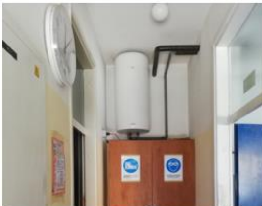
Slika 28: Električni grelnik vode
