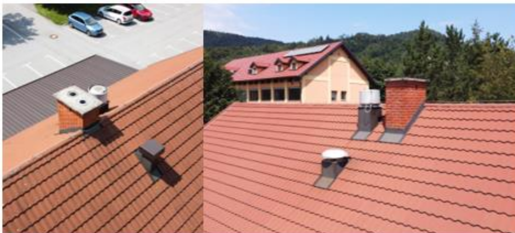
Slika 27: Levo, mesto vgradnje odstranjenega odvodnega ventilatorja sanitarij in desno, aktivna ventilatorja
