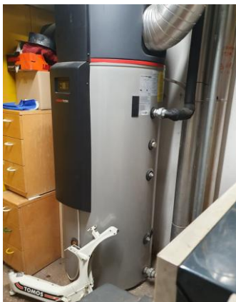
Sanitarna toplotna črpalka Kronoterm WP4 LF-502 za pripravo tople sanitarne vode (levo) in toplovodni sprejemniki sončne energije za pripravo tople sanitarne vode poleti (desno).
