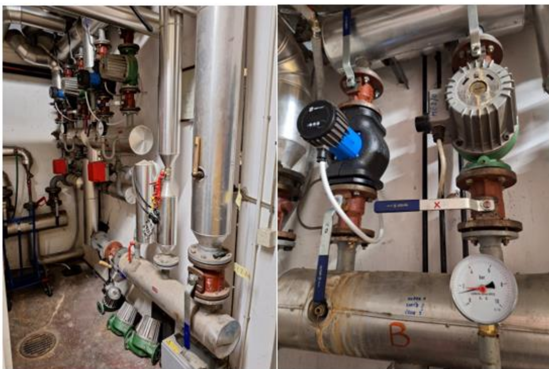
Slika 11: Levo, toplotni razdelilec in desno, ogrevalna veja z vgrajeno primarno in rezervno obtočno črpalko
