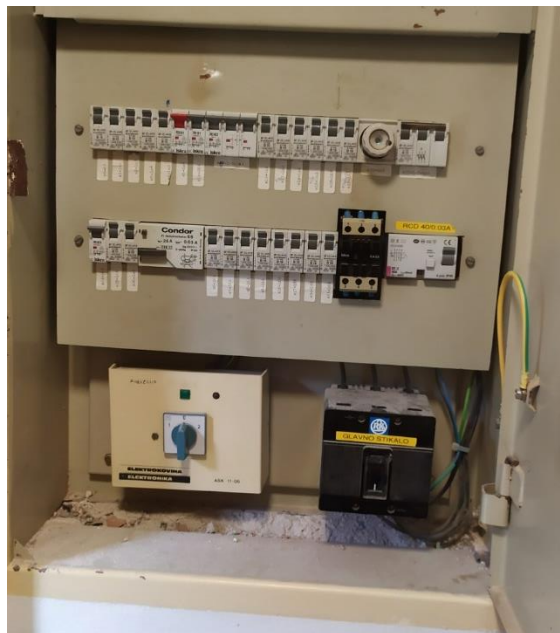
Slika 53: Tipična glavna elektro omarica v stanovanjskih enotah
