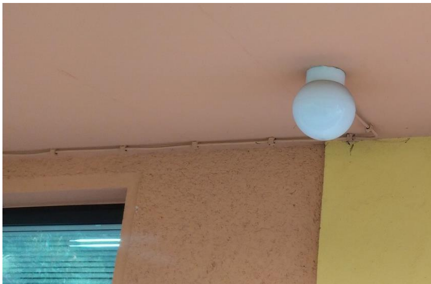
Slika 47: Električna napeljava zunanje razsvetljave
