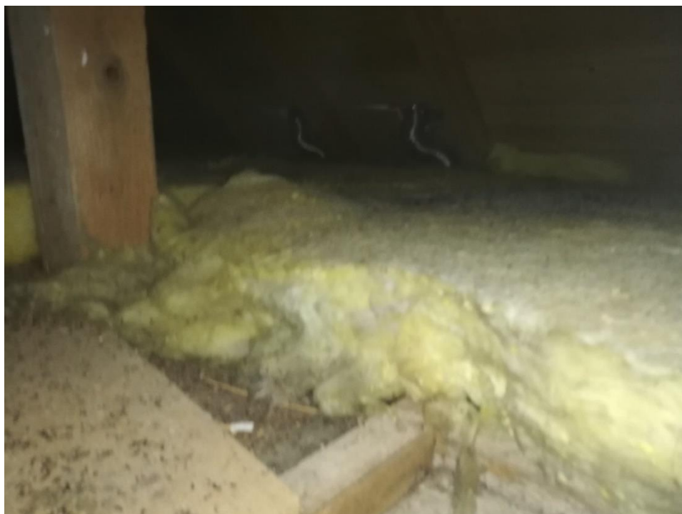
Slika 89: Prikaz neustrezno izvedenega polaganja toplotne izolacije na tleh neogrevanega podstrešja (steklena volna)
