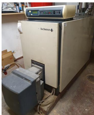
Kotel na ELKO De Dietrich (levo) in zalogovnik za toplo sanitarno vodo (sredina), vezan na sanitarno TČ, kotel ELKO in sprejemniki sončne energije na strehi ter radiator s termostatskim ventilom in glavo (desno).
