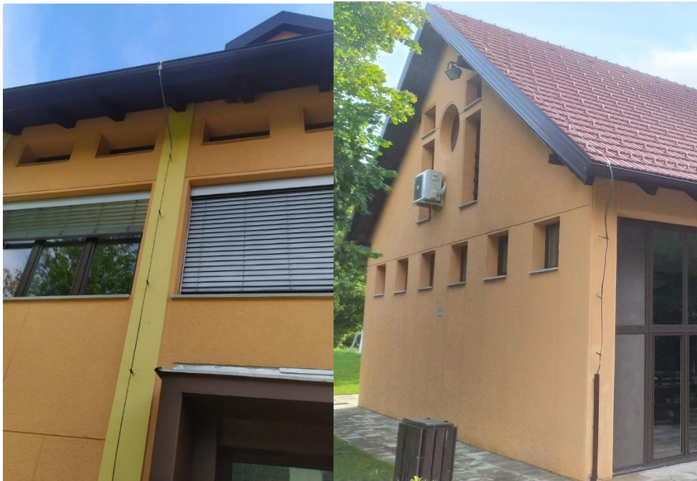
Slika 48: Strelovod na glavni stavbi
