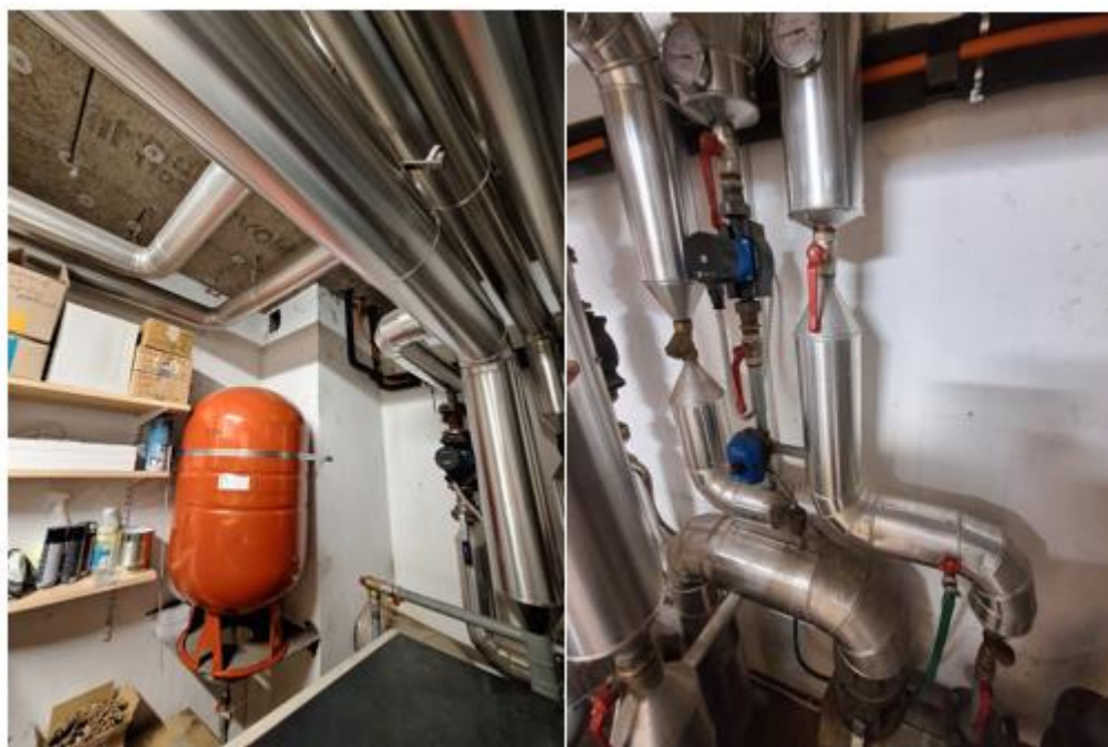
Slika 12: cevni vodi za distribucijo toplote so ustrezno toplotno izolirani in zaščiteni z Al plaščem
