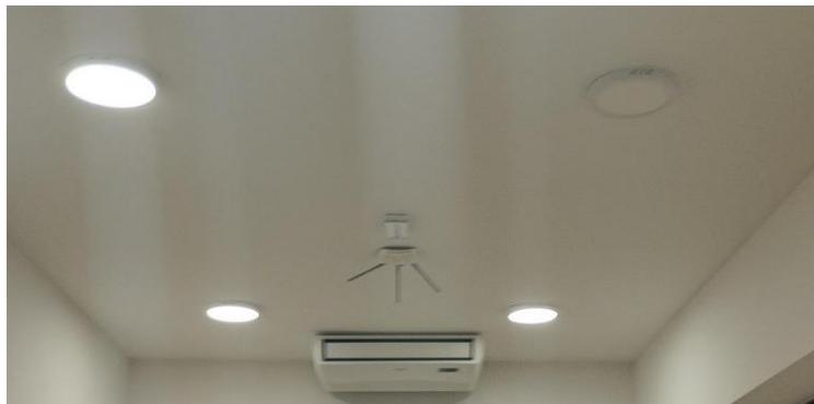
Slika 36: LED vgradne sijalke (15 W)
