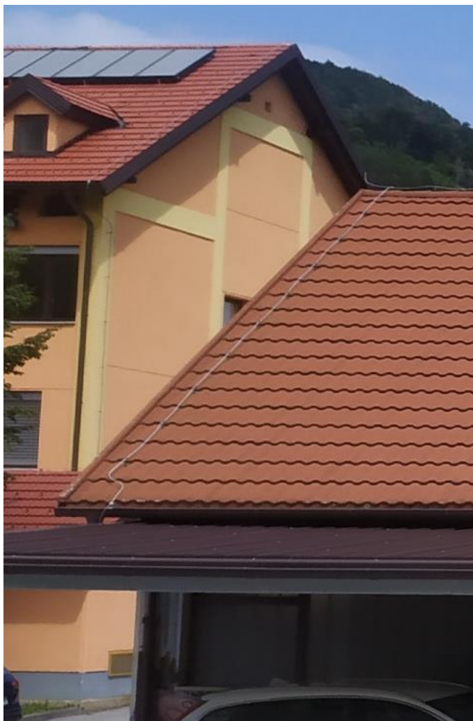
Slika 50: Strelovod na strehi delavnice.
