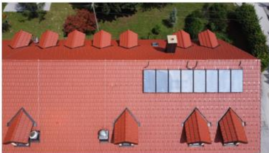
Slika 15: Solarni kolektorji na strehi glavne stavbe
