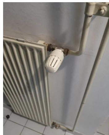
Kotel na ELKO De Dietrich (levo) in zalogovnik za toplo sanitarno vodo (sredina), vezan na sanitarno TČ, kotel ELKO in sprejemniki sončne energije na strehi ter radiator s termostatskim ventilom in glavo (desno).
