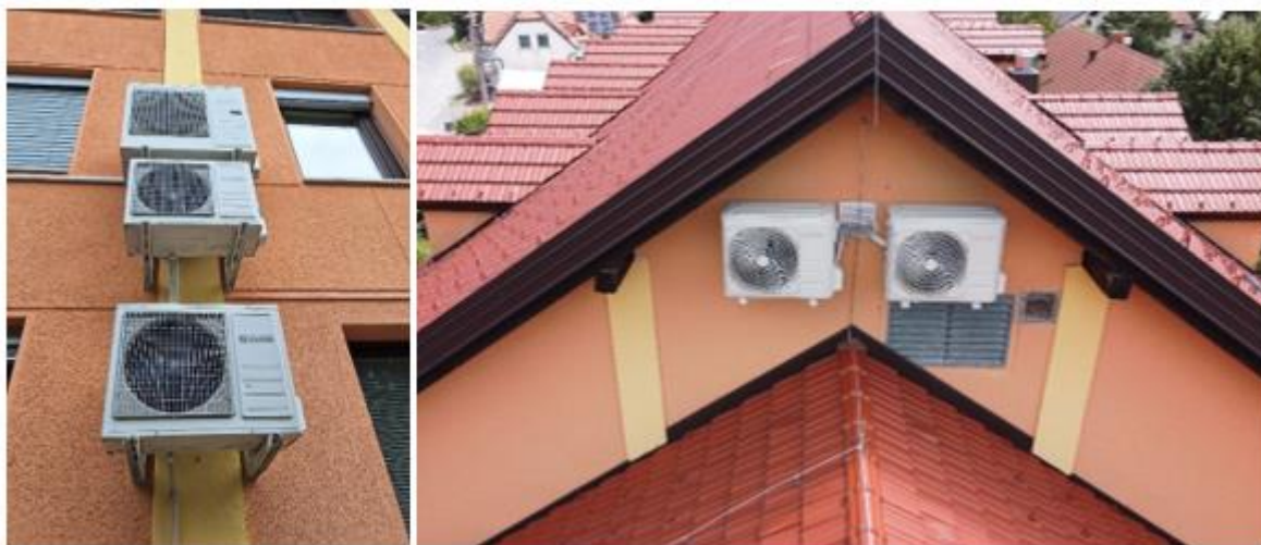
Slika 19: Zunanje enote SPLIT klimatskih naprav
