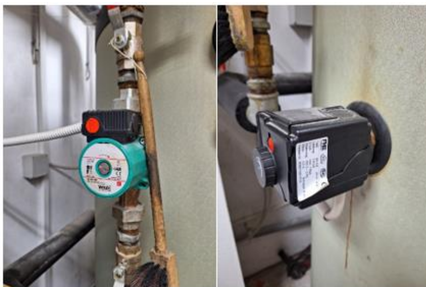
Slika 17: Levo, cirkulacijska črpalka STV in desno, električni grelnik na hranilniku STV
