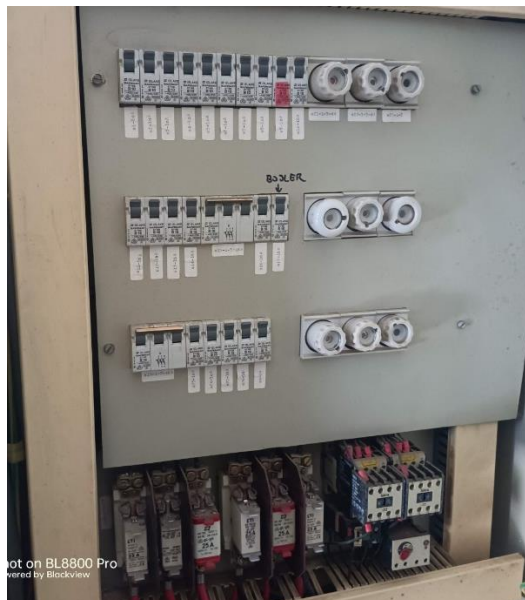
Slika 49: Razdelilna elektro omarica RC-1
