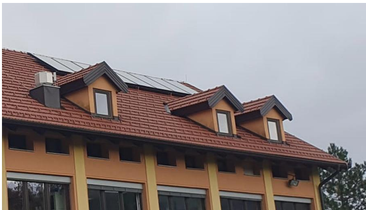
Sanitarna toplotna črpalka Kronoterm WP4 LF-502 za pripravo tople sanitarne vode (levo) in toplovodni sprejemniki sončne energije za pripravo tople sanitarne vode poleti (desno).
