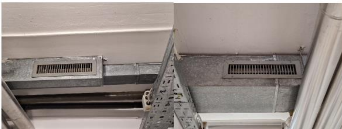
Slika 21: Dovodni in odvodni prezračevalni kanal z regulacijsko rešetko
