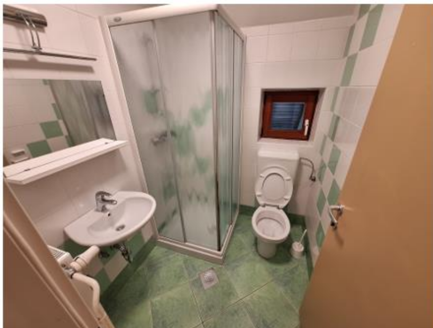
Slika 33: Porabniki sanitarne vode, umivalnik in tuš z enoročno armaturo in WC splakovalnik
