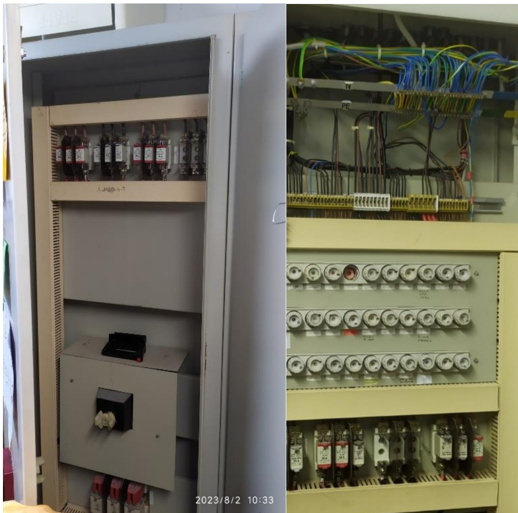
Slika 44: Levo glavna elektro omara R-G, desno razdelilna elektro omara R-K/B
