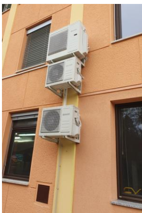
Zunanje enote split hladilnih naprav na JZ fasadi objekta.
