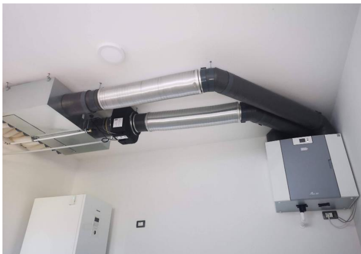
Slika 110: Razvod prezračevalnega sistema
