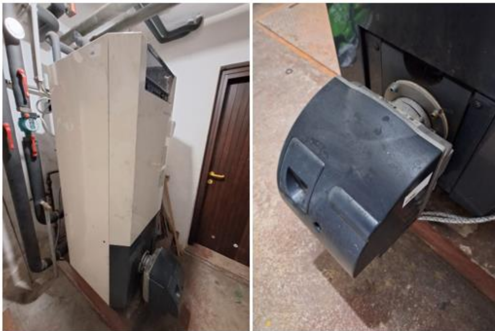
Slika 29: Levo, Kotel De Dietrich in desno, oljni gorilnik De Dietrich
