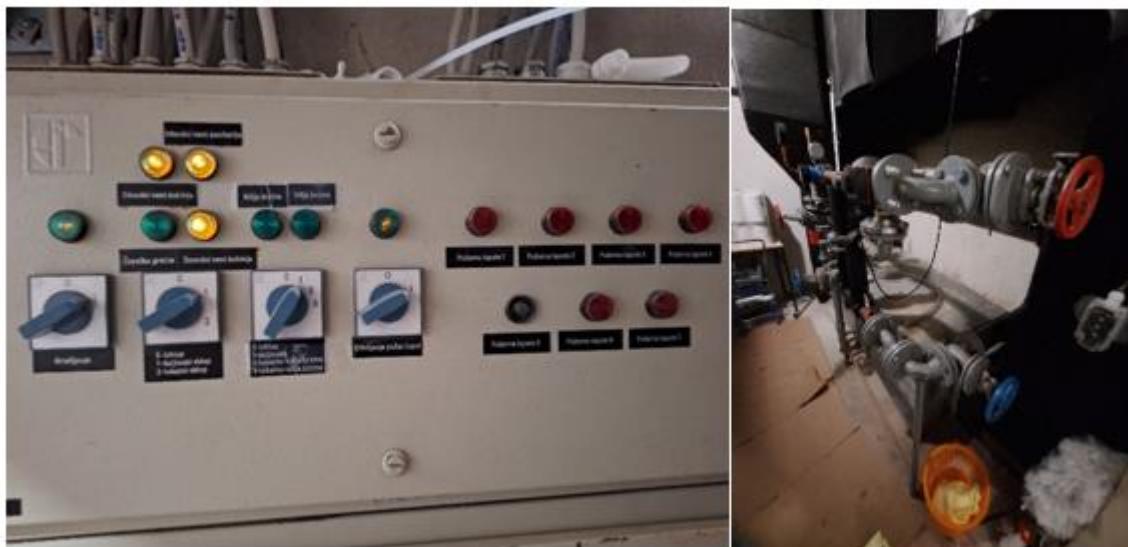
Slika 22: Levo, krmilna omara prezračevalnega sistema in desno, cevna povezava toplotnega registra klimata
