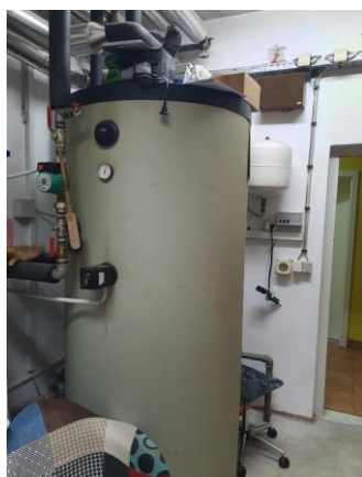
Kotel na ELKO De Dietrich (levo) in zalogovnik za toplo sanitarno vodo (sredina), vezan na sanitarno TČ, kotel ELKO in sprejemniki sončne energije na strehi ter radiator s termostatskim ventilom in glavo (desno).
