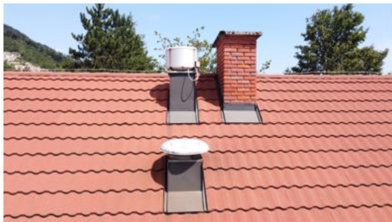
Slika 26: Odvodni ventilator 1 ter izpuh odvodnega ventilatorja 2 na strehi delavnice
