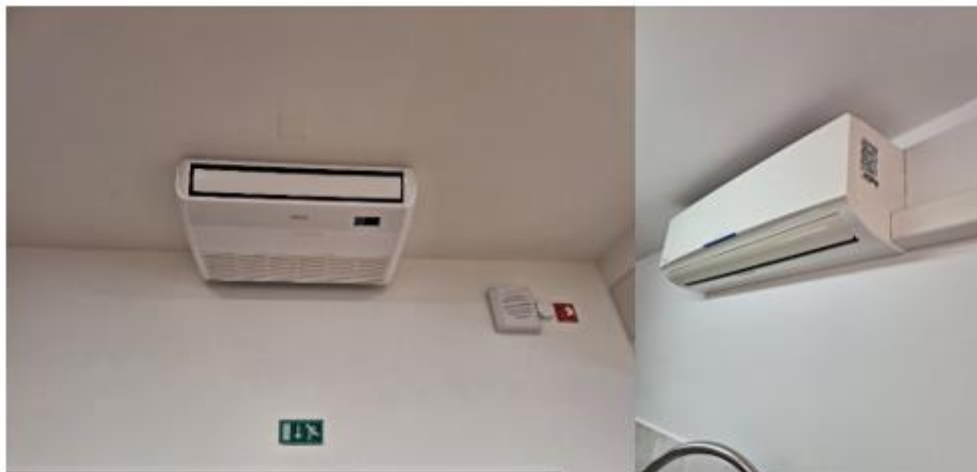
Slika 20: Notranja stropna enota SPLIT klimatske naprave levo in notranja stenska enota desno
