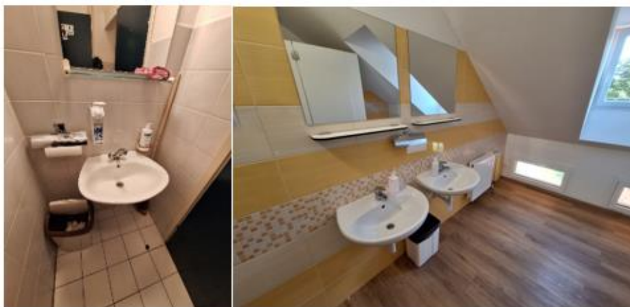
Slika 24: Porabniki sanitarne vode, umivalniki z dvoročno in enoročno armaturo
