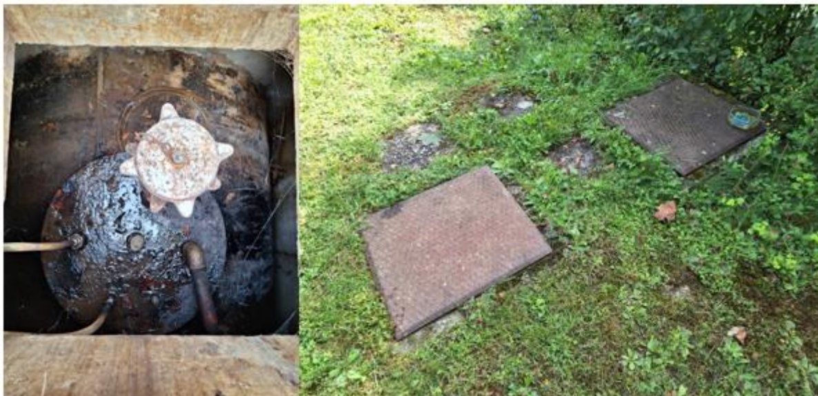
Slika 13: Levo, ELKO rezervoar s polnilnim ventilom in desno, jaška rezervoarja
