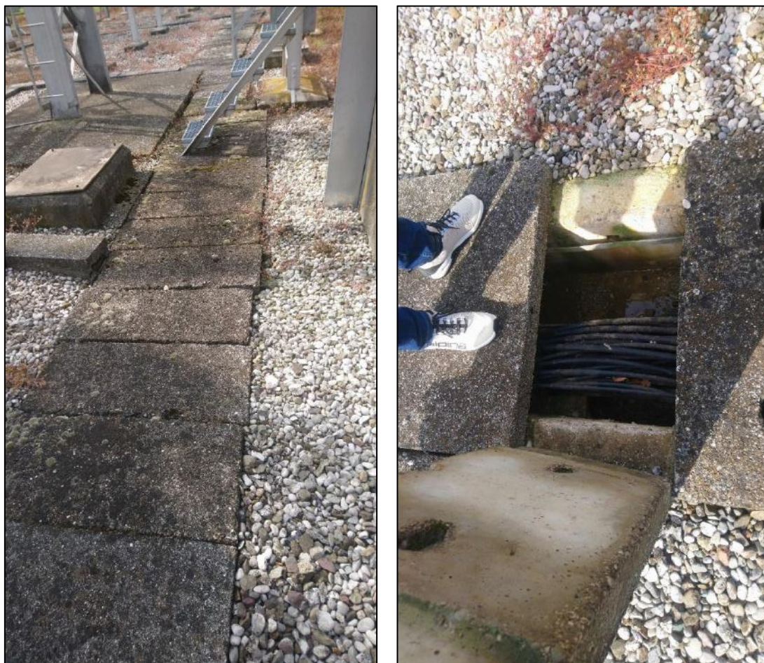
Slika 16: AB kabelski zbirni kanal - kineta
