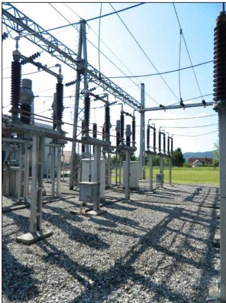
Slika 17: Gramozno nasutje površin stikališča
