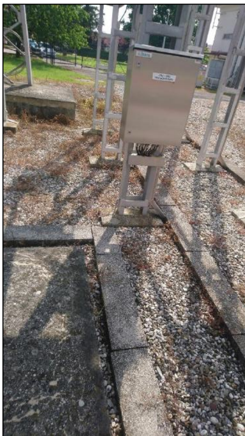
Slika 15: Kabelska kanalizacija - AB kinete
