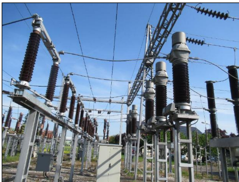
Slika 14: Jekleni podstavki opreme
