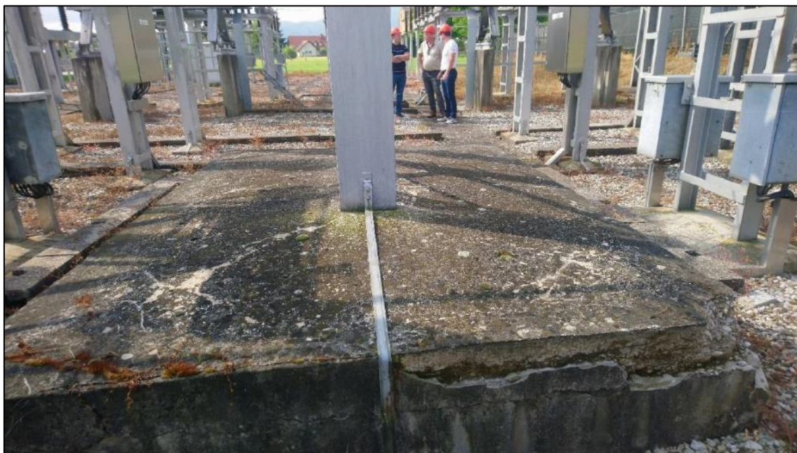
Slika 12: Kape AB temeljev portalov
