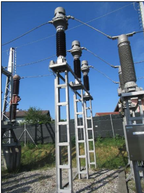
Slika 13: Jekleni podstavki opreme
