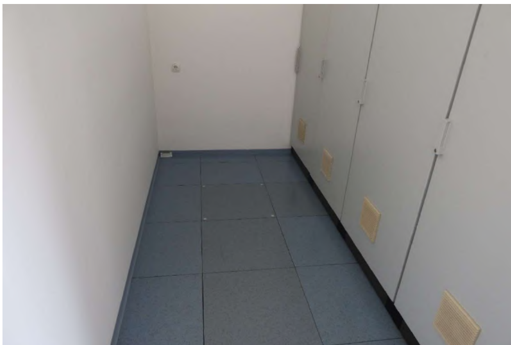
Slika 3-9: Prikaz obstoječega dvojnega poda v relejni hišici
