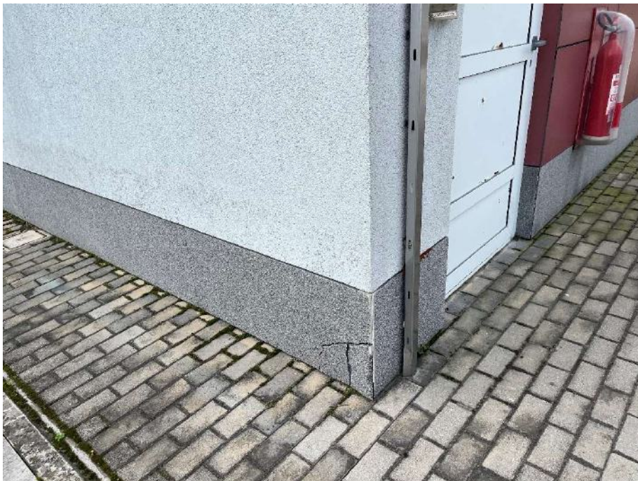
Slika 3-5: Prikaz poškodbe cokla relejne hišice
