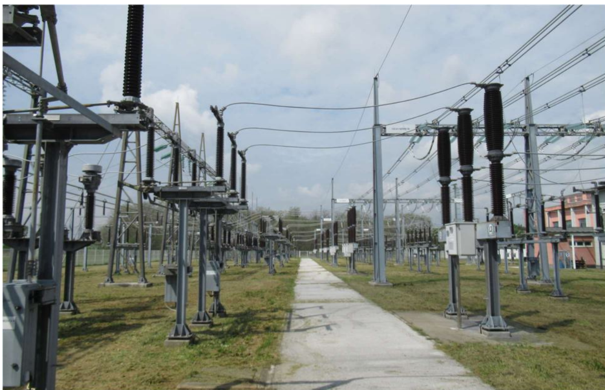
Slika 2-4: Portali in podstavki VN aparatov, slika 1
