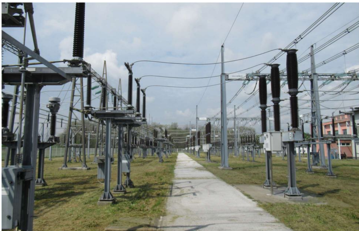
Slika 2-1: Portali in podstavki VN aparatov, slika 1
