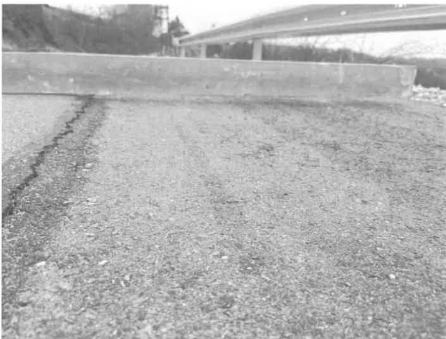
Fotografija 7. Deformacija 2cm
