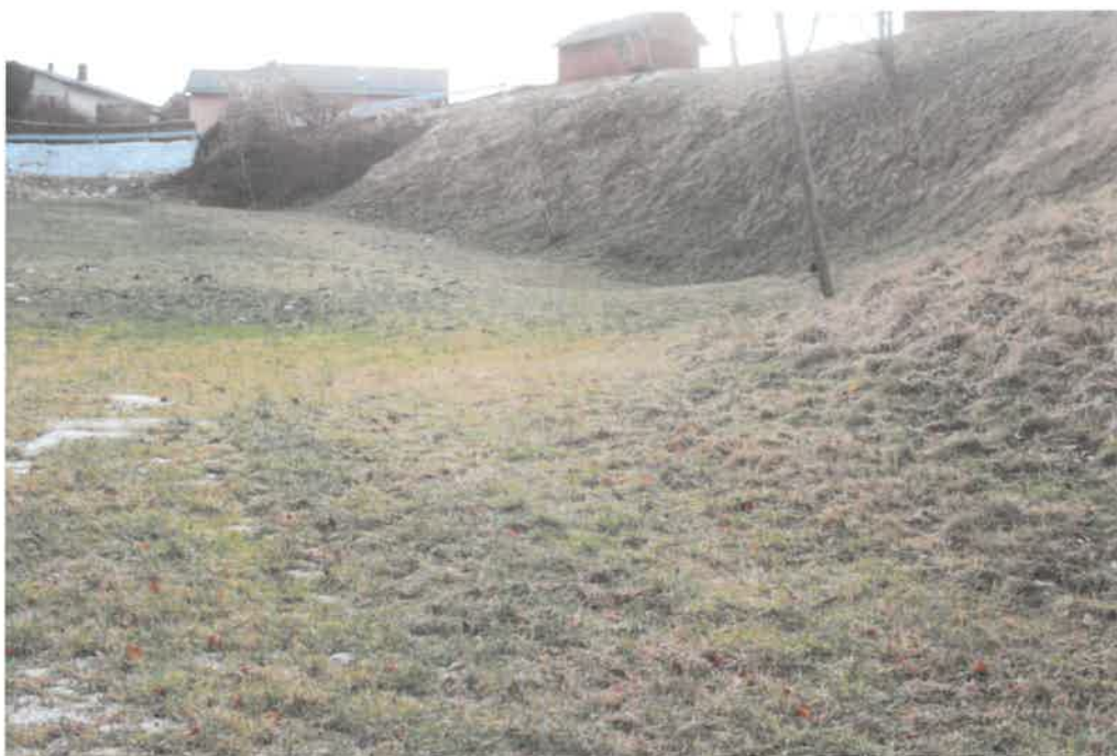
Fotografija 11. Pogled iz doline proti cesti v desni nestabilni rob, kjer se vidi strmi vpad terena in so vidni prečni narivni robovi na travniku, viden je tudi pojav vrtače.
