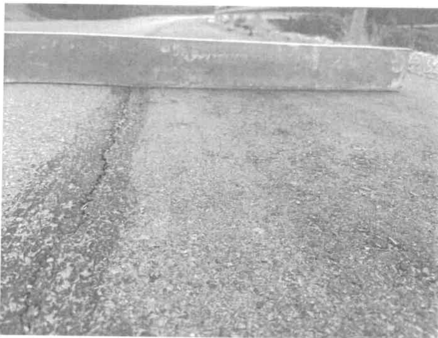
Fotografija 6 Deformacija 1cm
