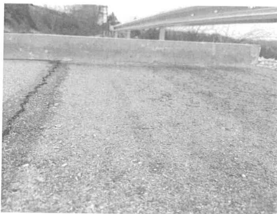
Fotografija 7. Deformacija 2cm
