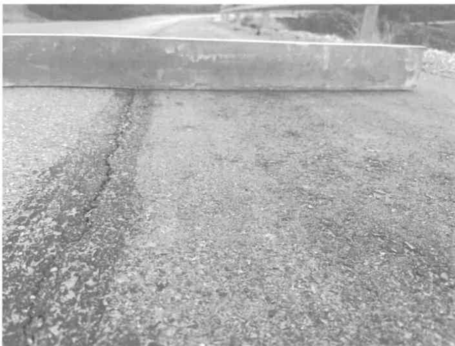
Fotografija 6 Deformacija 1cm
