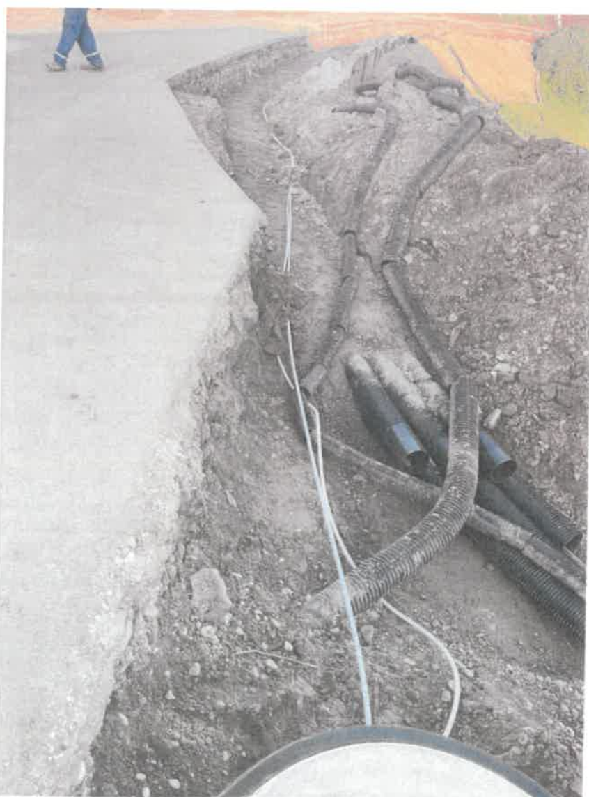
Fotografija 5.. Pogled na vgrajene cevi za Elektro vod.
