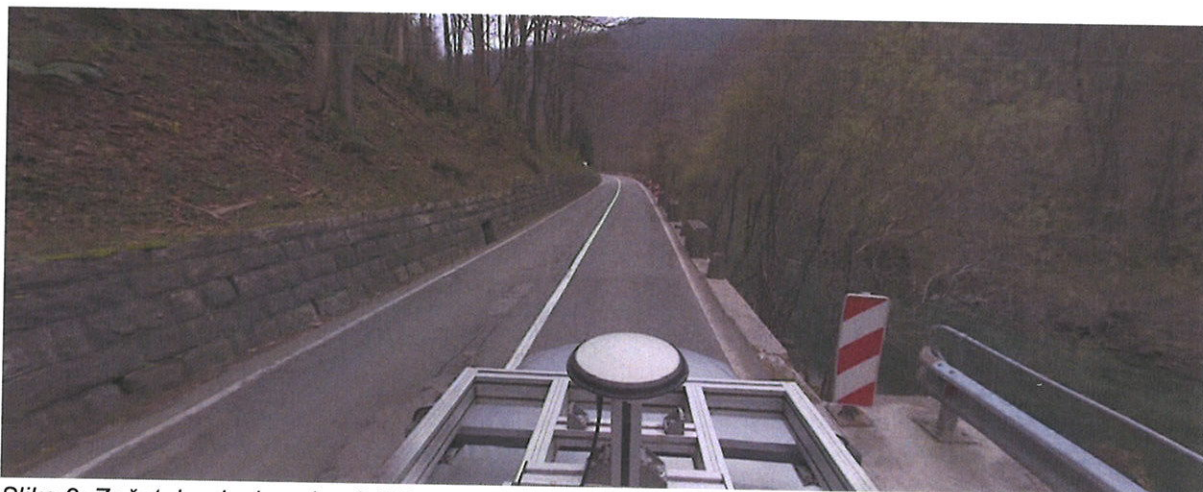
Slika 2: Začetek odseka v km 9,572 brez ustrezne varovalne ograje
