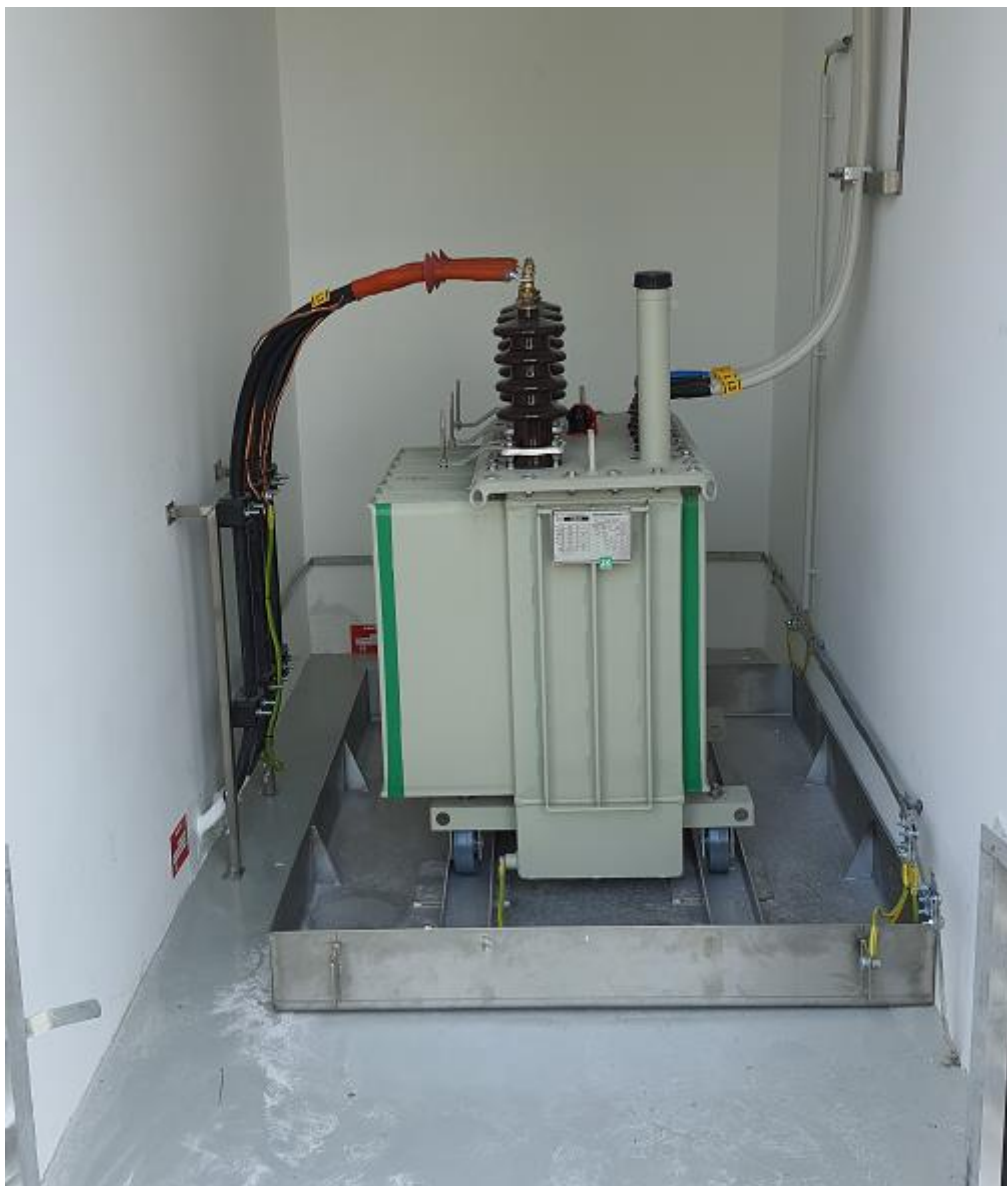
Slika 5-1: Primer vgradnje in montaže TR
