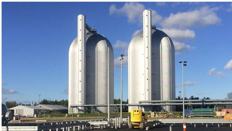
Slika 19: Primer dveh nadzemnih rezervoarjev - stratifikacijskih hranilnikov toplote za dvodnevno shranjevanje toplote v Copenhagenu [31].
