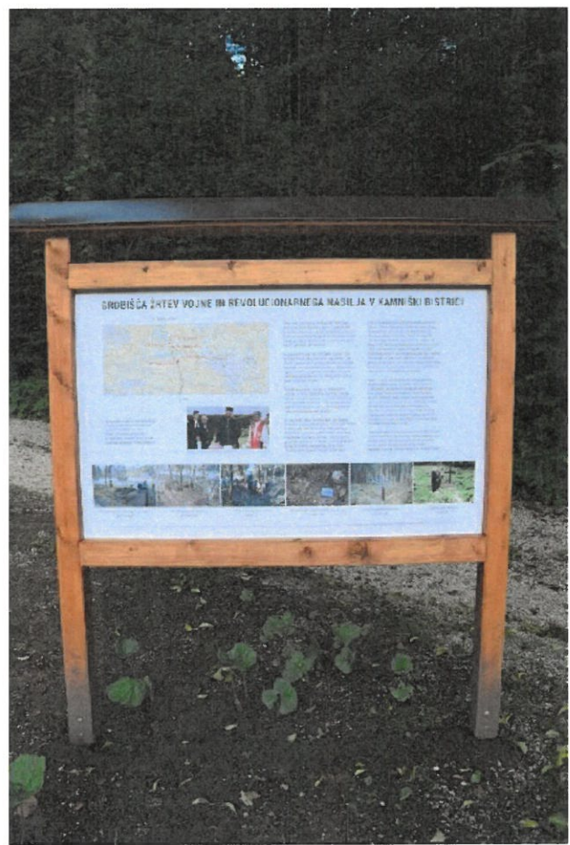
Slika 13: Informacijska tabla izdelana iz dibona, na masivnem podstavku z streho
