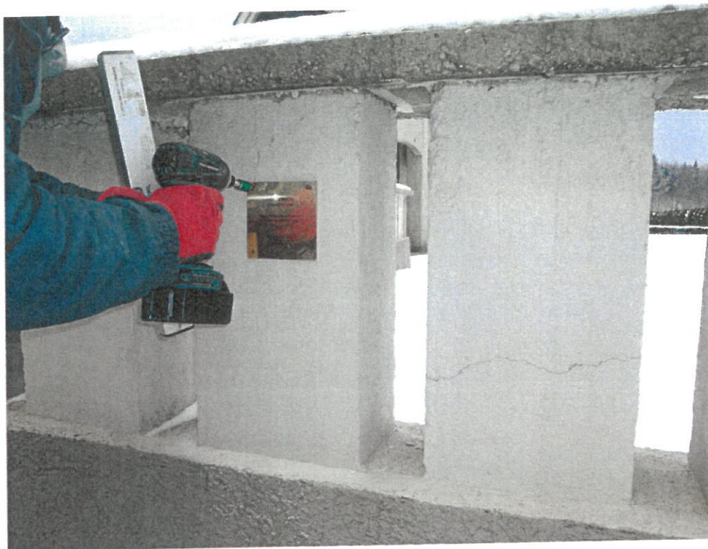
Slika 2 pritrjevanje medeninaste ploščice
