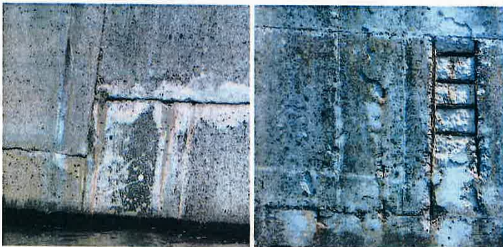
Slika 15: Karakteristična odstopanja na zidu
