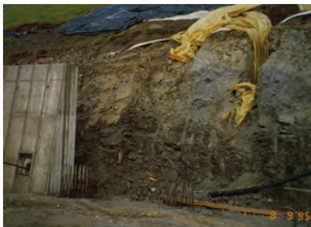
Izvedba gradnje VA6260 – vgrajeni piloti, izdelan AB zid, vgrajena geotehnična sidra, izdelane drenažne vrtnice za zidom. Desno – gradnja zidu, plazovita zaledna brežina, pokrita s PVC folijo. September 1995.
