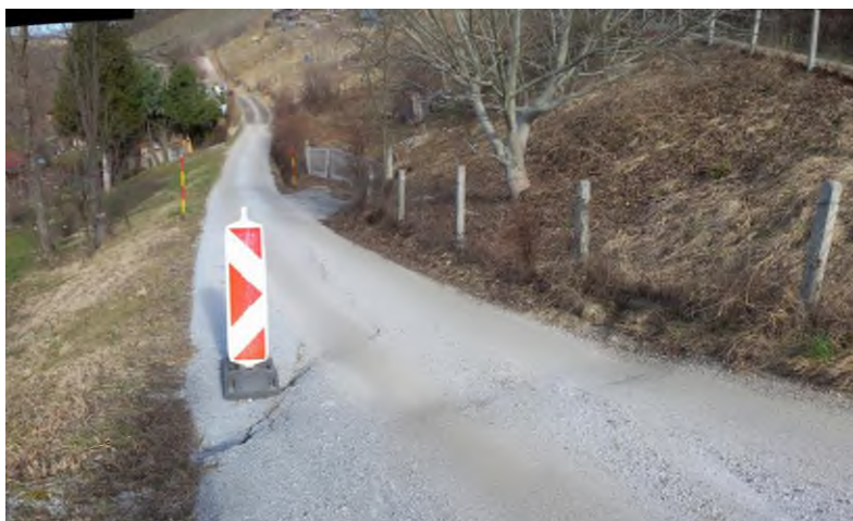
Razpoke in odlomni robovi na cesti 743092 severno od kašte VA6261 – februar 2024.
