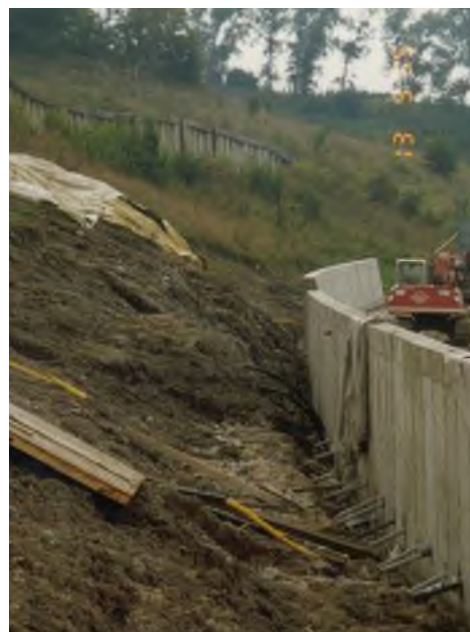
Detajl izvedbe vgradnje geotehničnih sider – različen naklon geotehničnih sider. Desno – vgrajena geotehnična sidra, vidne so drenažne vrtine v zaledje (črne in rumene cevi). September 1995.
