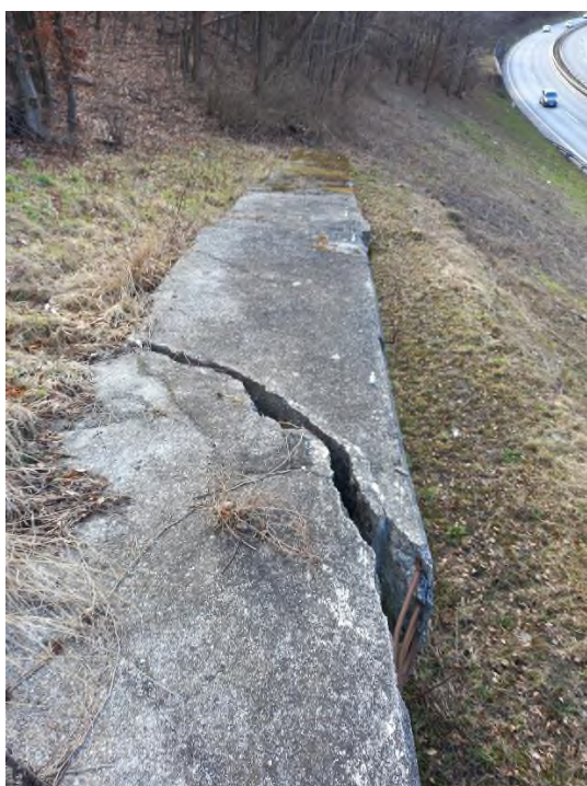
Poškodovana vezna greda širine 170 cm debeline 40 cm na južnem delu PS 9.
