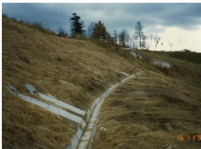
Izvedene drenažne vrtine in kanaleta na prvi bermi nad VA6260 in deformiran teren pod PS9 (VA6263) novembra 1995.
