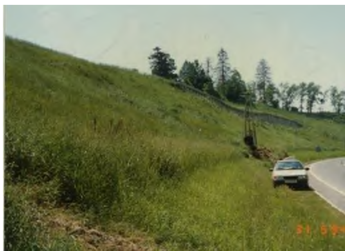
Izvedba geomehanskih vrtin na območju plazenja pobočja med kašto (VA6261) in PS9 (VA6263) – maj 1994.
