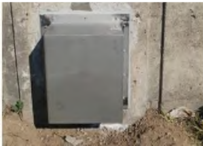
Detajl saniranega sidra in novega pokrova na VA6260, sidro brez elektroizolacijskega obroča – leto 2018 (vir poročilo št. 039/2018, Specialna geotehnika, Matjaž Klinc s. p.)
