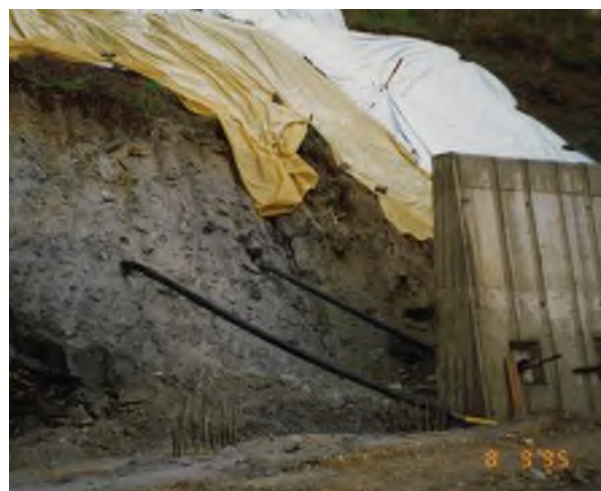
Gradnja VA6260 septembra 1995. Desno – prikaz detajla drenažnih vrtnic za AB zidom v debelejši kompaktni plasti laporovca.
