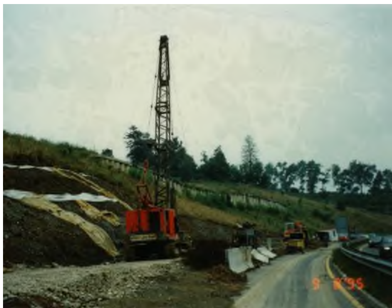
Izdelava delovnega platoja in izvedba AB pilotov premera 80 cm, pilotna stena (VA6260), avgust 1995.
