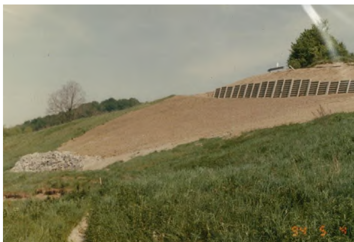
Pogled na izdelane oporne konstrukcije – kašte in kamnita zložba v maju 1994 (projekt GRADING d.o.o., št. 213; izvedba 1993-1994), desno vidno aktivno plazenje pobočja.
