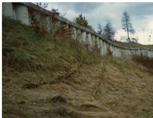
Izvedene drenažne vrtine in kanaleta na prvi bermi nad VA6260 in deformiran teren pod PS9 (VA6263) novembra 1995.
