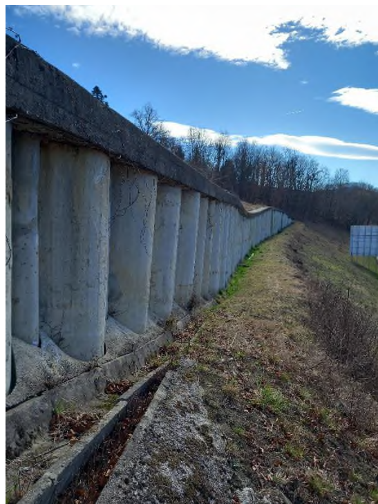
Nagnjeni piloti in deformacije odvodnega sistema na spodnji strani PS9 (VA6263).
