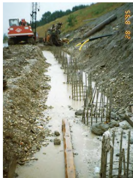
Izdelava delovnega platoja in izvedba AB pilotov premera 80 cm, pilotna stena (VA6260), avgust 1995.
