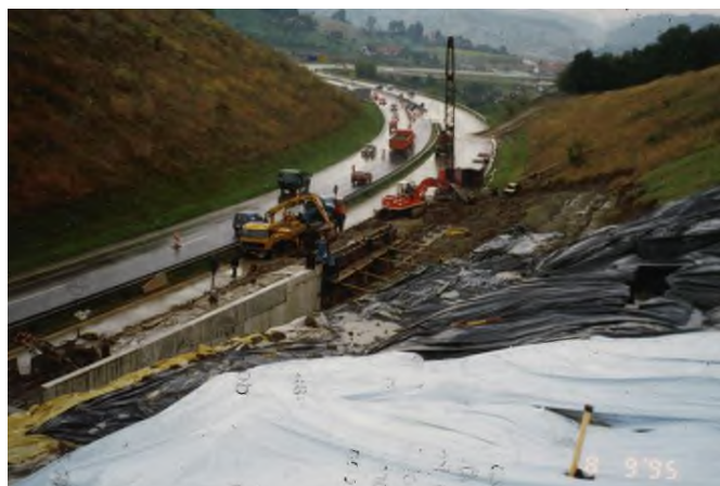
Izvedba gradnje VA6260 – vgrajeni piloti, izdelan AB zid, vgrajena geotehnična sidra, izdelane drenažne vrtnice za zidom. Desno – gradnja zidu, plazovita zaledna brežina, pokrita s PVC folijo. September 1995.
