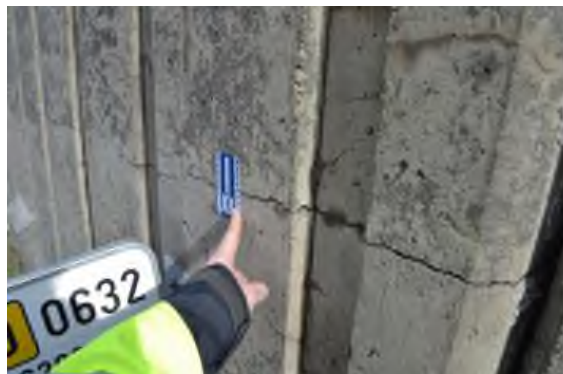
Primer razpoke širine do 2 mm v AB zidu VA6263 (ZAG, februar 2024).
