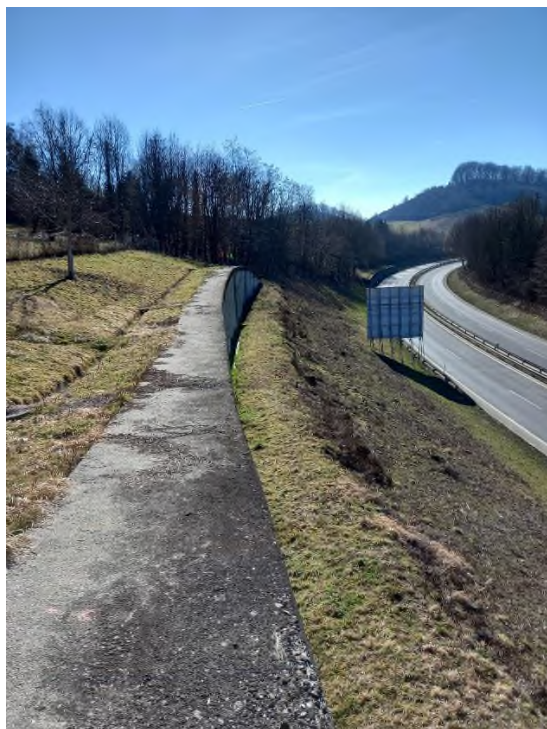
Detajl poteka vezne grede in zalednih kanalet in odvodnjavanja – februar 2024.
