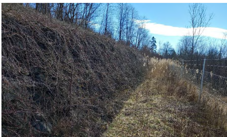
Levo pogled na preraščeno kamnito-betonsko zložbo, izdelano leta 1994 med kaštami in pilotno steno VA6260 – stanje 2024.
