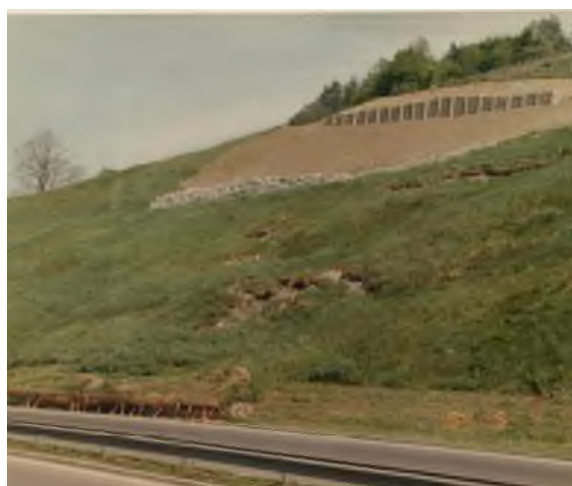
Pogled na izdelane oporne konstrukcije – kašte in kamnita zložba v maju 1994 (projekt GRADING d.o.o., št. 213; izvedba 1993-1994), desno vidno aktivno plazenje pobočja.
