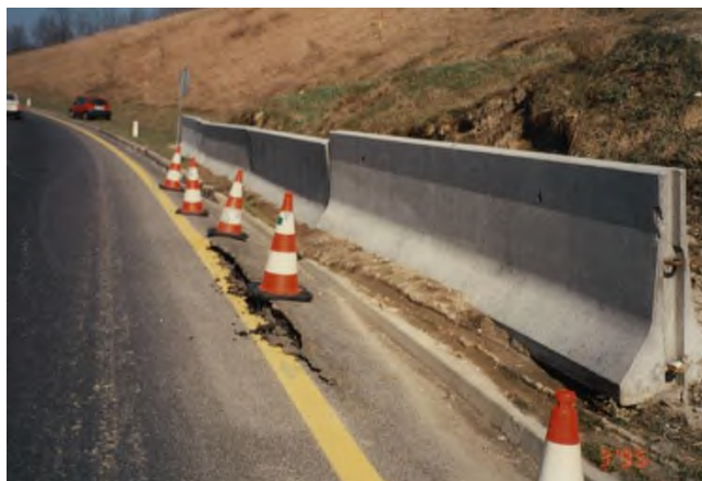
Poškodbe na vozišču – izrivni rob plazu in stanje pobočja med HC, PS9 in zaledno cesto. Napredovanje plazenja. Marec 1995.
