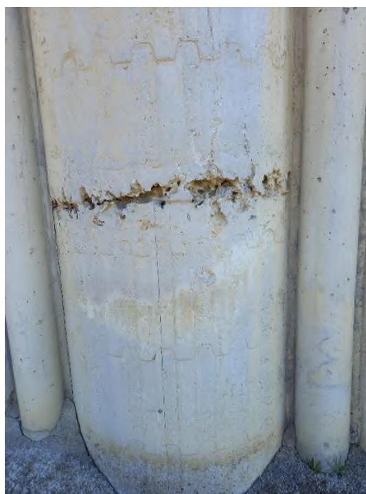
Detajl poškodbe na AB pilotu premera 150, tudi več prečni razpok preko pilotov.
