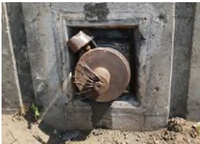
Detajl saniranega sidra in novega pokrova na VA6260, sidro brez elektroizolacijskega obroča – leto 2018 (vir poročilo št. 039/2018, Specialna geotehnika, Matjaž Klinc s. p.)
