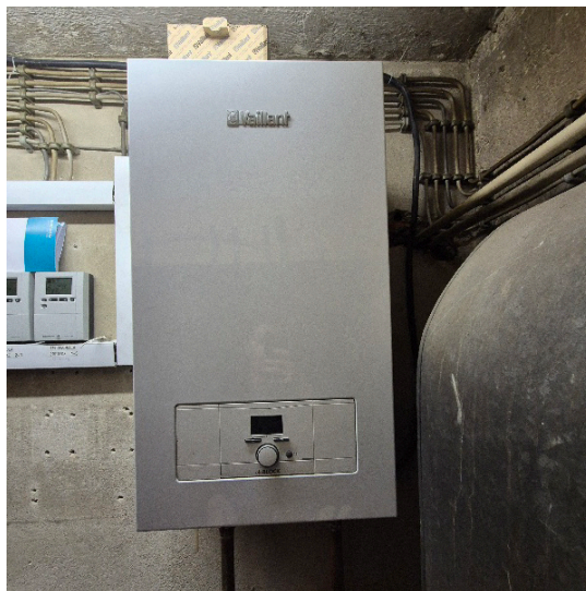
Slika 16: Električni kotel za pripravo TSV.
