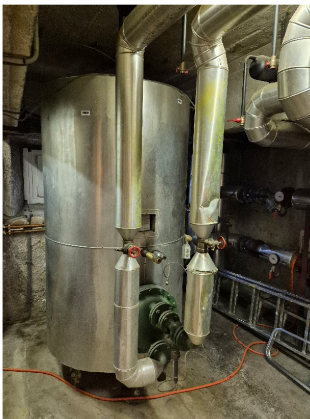
Slika 17: Bojler za pripravo TSV.
