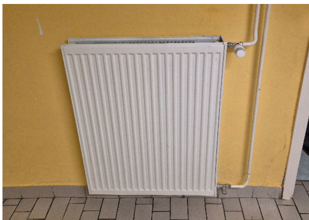
Slika 14: Radiatorsko ogrevanje - nameščeni termostatski ventili.
