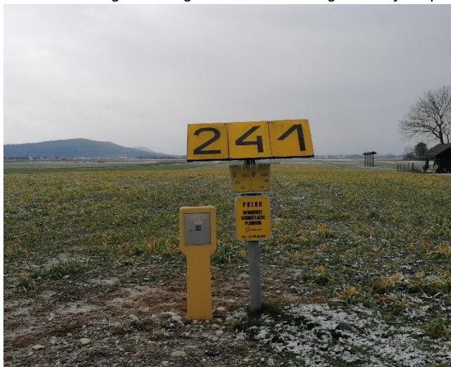
Primer izvedenega katodnega stebrička in zračnega markerja z opozorilno tablo
