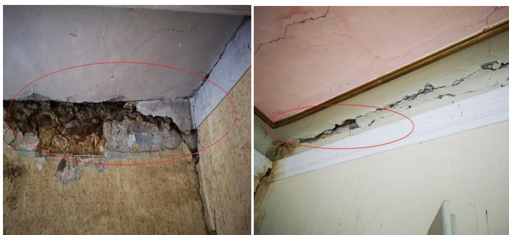
Razpoke na stiku zidu in stropa
