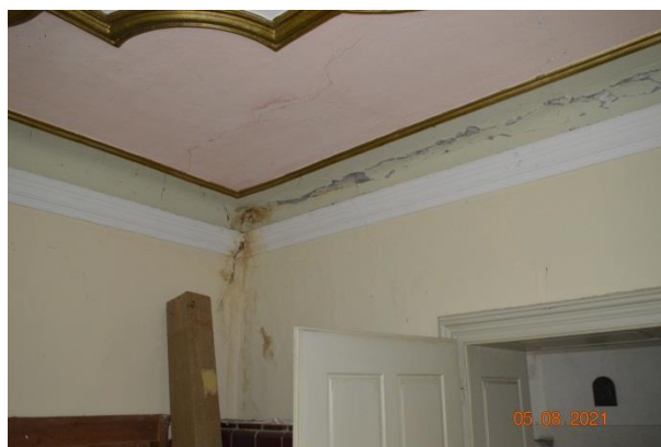
Slika 3-14 Oznaka poškodbe št. 324: Razpoka na stiku stene in stropa v prostoru NAD_39.
