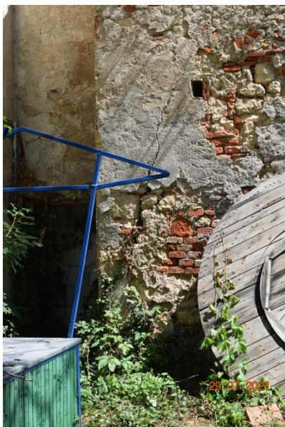
Slika 3-1 Oznaka poškodbe št. 9: Močna razpoka v pritličnem delu južne fasade, d = 50 mm.
