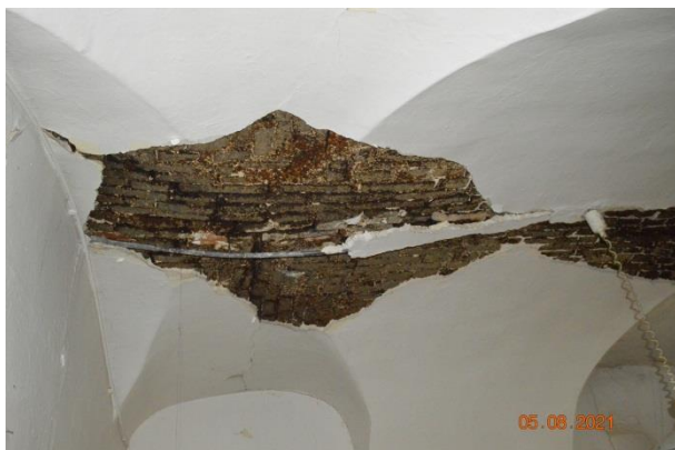
Slika 3-15 Oznaka poškodbe št. 367: Povešen in močno zamočen obokan strop v prostoru NAD_43. Omet stropa je že odpadel.
