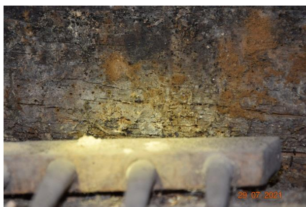
Slika 3-12 Oznaka poškodbe št. 210: Lesena konstrukcija močno napadena z lesnim črvom v prostoru PRI_21.
