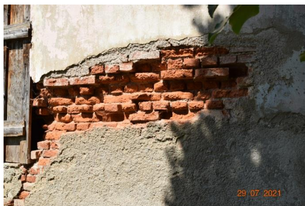
Slika 3-4 Oznaka poškodbe št. 25: Luščenje zidovine - opeke in malte.
