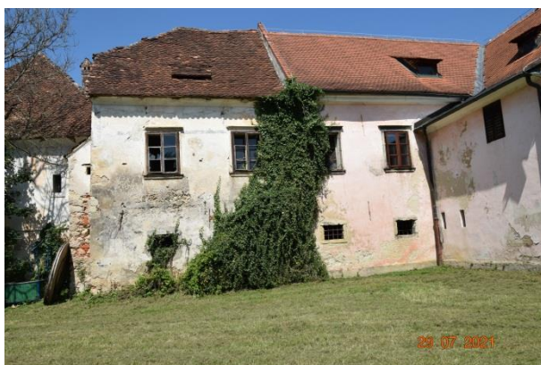
Slika 3-3 Oznaka poškodbe št. 16 in 17: Preraščanje fasade z ovijalko preko pritlične in nadstropne etaže.
