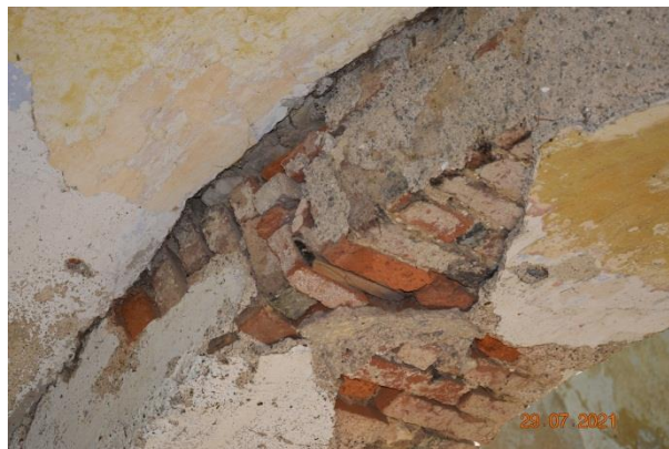
Slika 3-10 Oznaka poškodbe št. 208: Močno olušččen omet v oboku, razpoka v temenu oboka in premaknjene/povešene opeke v prostoru PRI_20.
