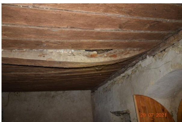
Slika 3-11 Oznaka poškodbe št. 178: Porušen stropnik v prostoru PRI_17.
