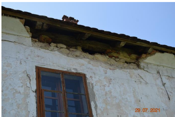
Slika 3-5 Oznaka poškodbe št. 56: Odpadanje pozidave (opeke in ometa) strešnega napušča.
