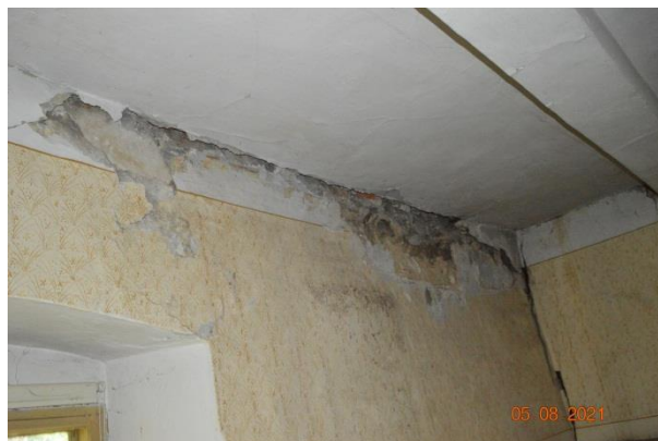
Slika 3-16 Oznaka poškodbe št. 377: Stena premaknjena iz svoje ravnine in razpoka na stiku stene in stropa v prostoru NAD_44.
