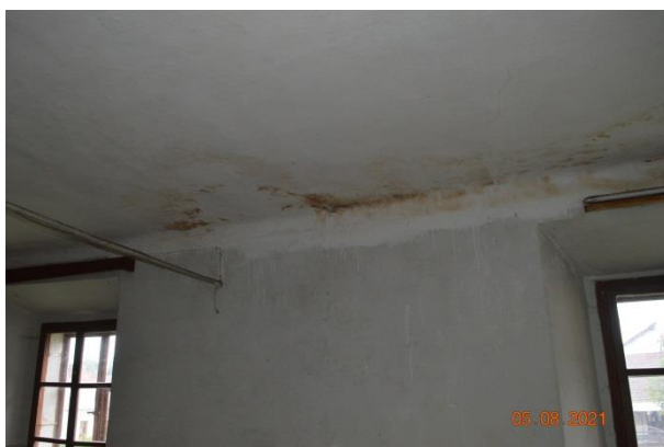
Slika 3-13 Oznaka poškodbe št. 278: Močno zamočen strop v prostoru NAD_33.
