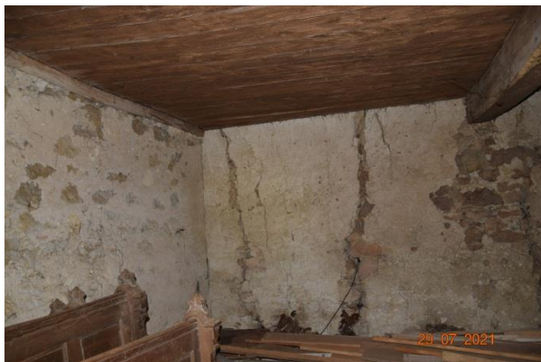
Slika 3-9 Oznaka poškodbe št. 181: močno razpokan zid v prostoru PRI_17.
