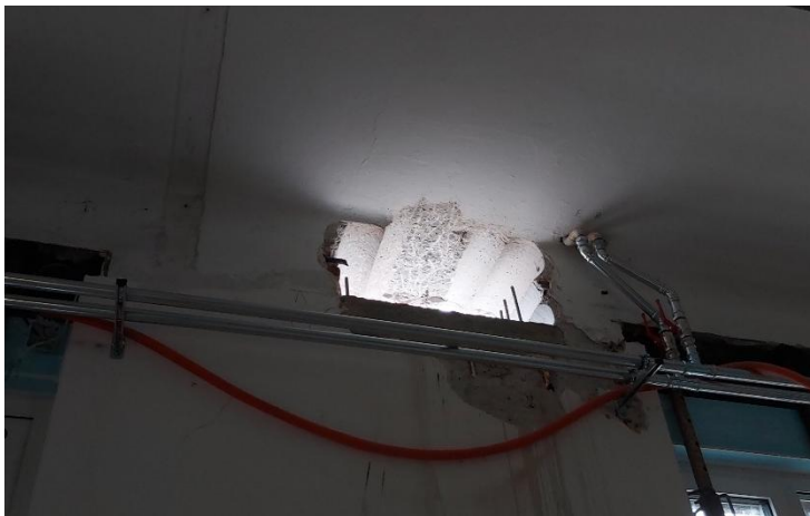
Slika 3: Priprava ležišča za branasto konstrukcijo
