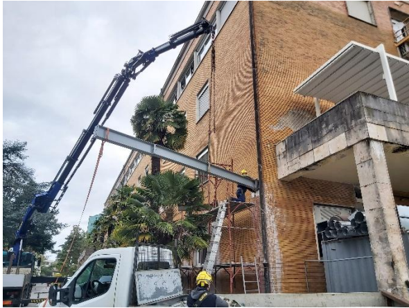
Slika 4: Primer vstavljanja dolgih jeklenih elementov skozi zunanje preboje
