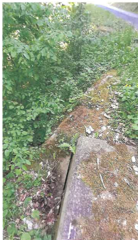
Posedki zaključkov na krajnih delih zidu
