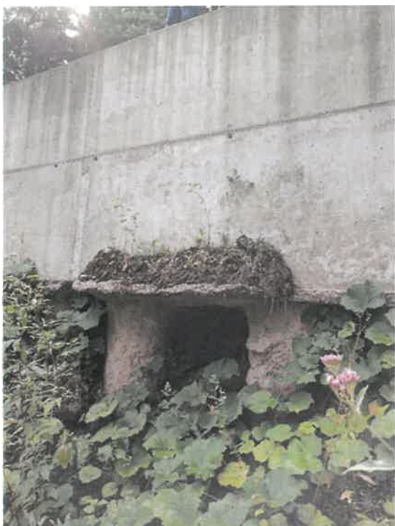
Usad na sredini pilotne stene
