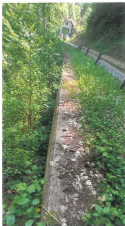
Venec pilotne stene na levi strani ceste
