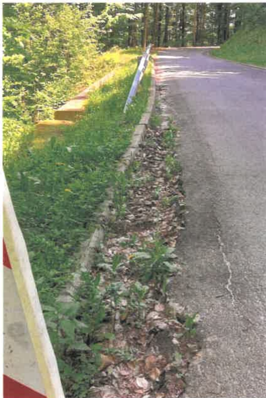
»Splazela« koritnica in robniki na koncu pilotne stene v km cca 9,830
