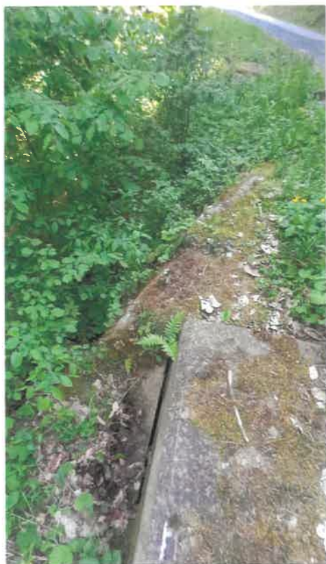
Posedek na koncu venca pilotne stene
