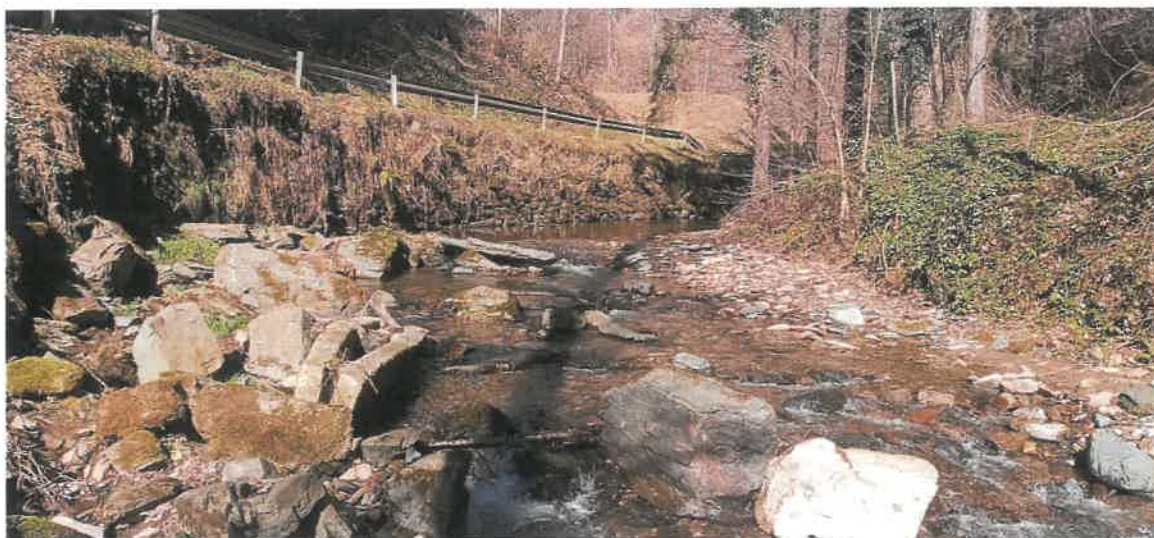
Porušeni del zidu podpornega zidu v pod cesto
