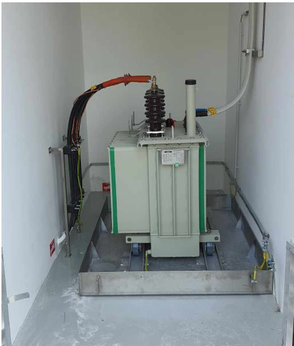
Slika 5-1: Primer vgradnje in montaže TR z oljnim lovilec
