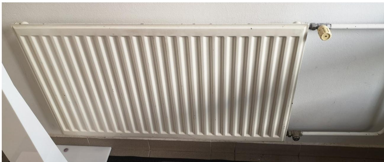
Slika 15: Radiatorji na vhodu v stavbo.
