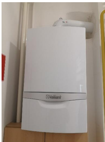
Slika 16: Centralna priprava sanitarne tople vode s pretočnim plinskim kotlom.
