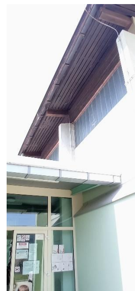
Slika 21: Povezovalni hodnik in JZ fasada telovadnice.
