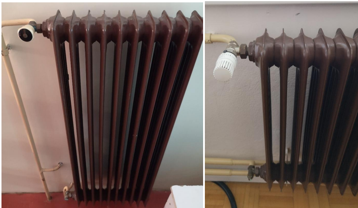
Slika 16: Členasti radiator z navadnim ventilom v garderobi (levo); členasti radiator s termostatskim ventilom v pisarni (desno).
