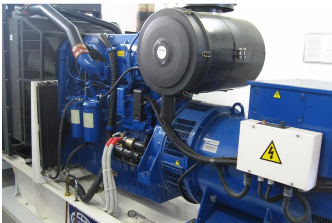
Slika 2: Dizel električni agregat
