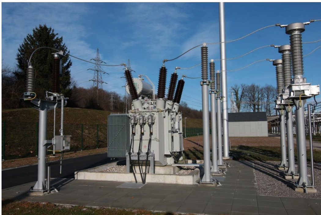
Slika 10: TR LR 110/20 kV, moči 4 MVA
