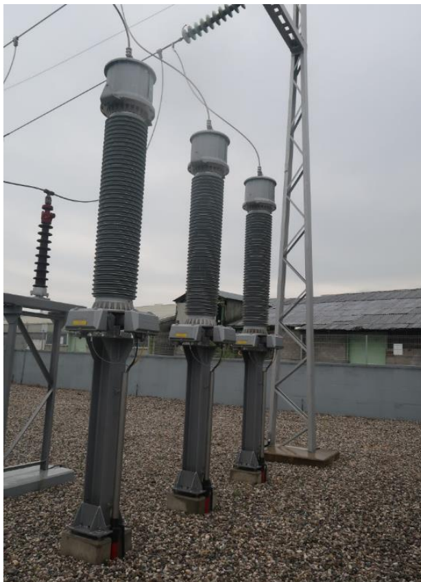
Slika 7: Napetostni napajalni transformatorji (NNT)
