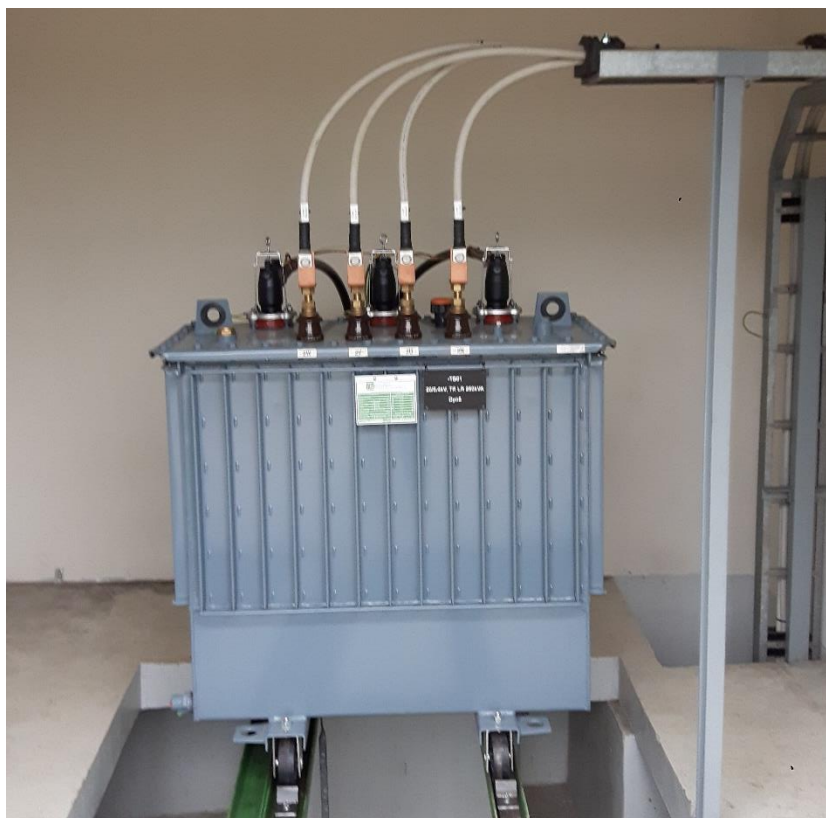
Slika 1: Transformator lastne rabe 20/0,4 kV
