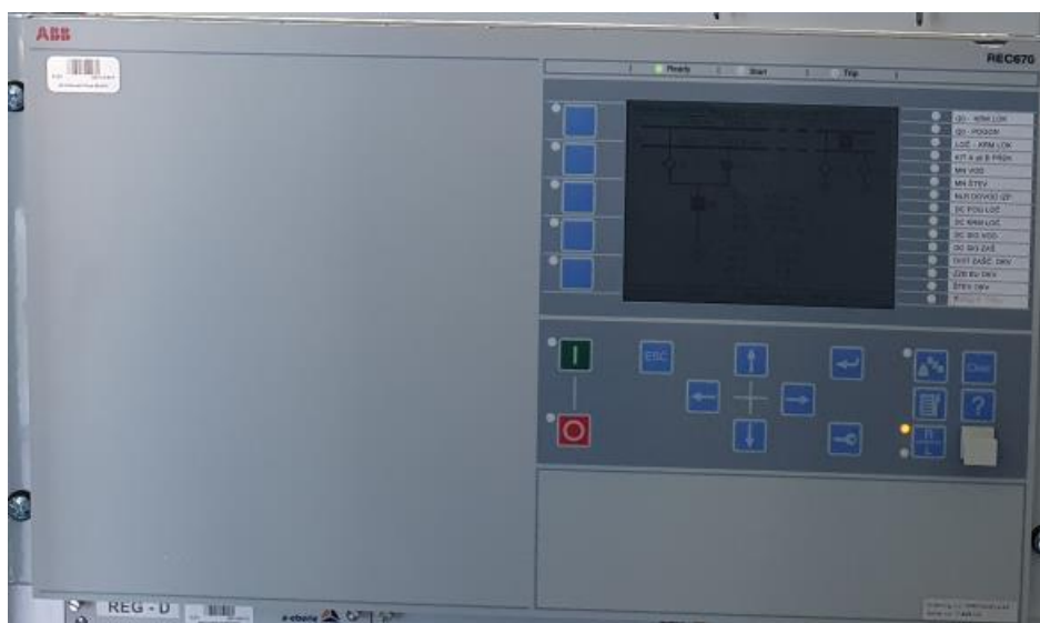
Slika 9: Računalnik polja ABB REC670
