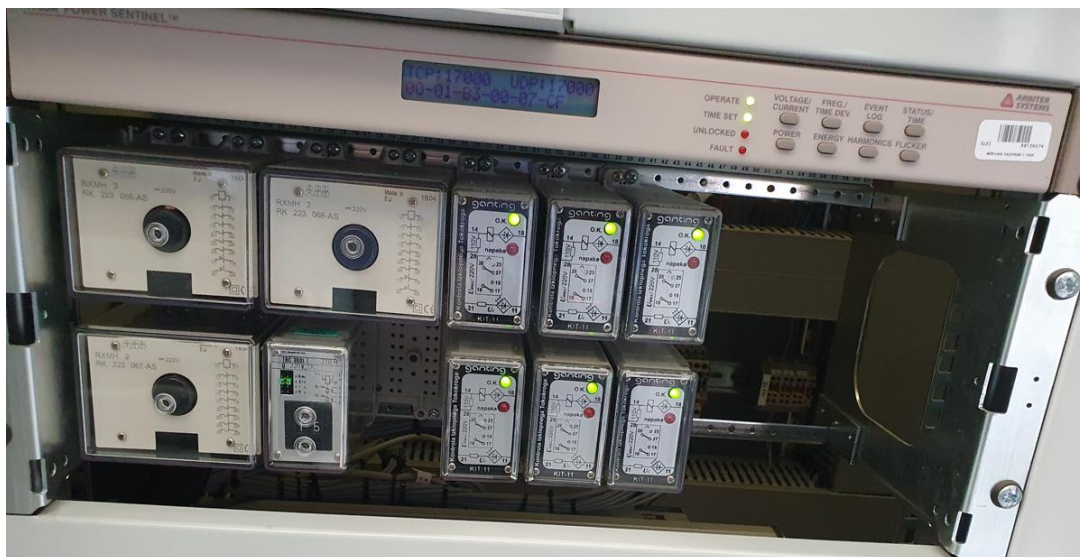
Slika 7: Tipična konfiguracija relejev v podnožju »Combiflex«
