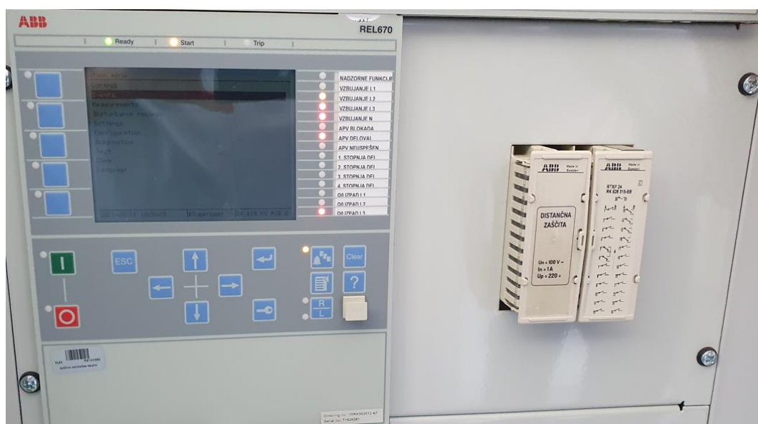
Slika 3: Terminal distančne zaščite ABB REL670 s preizkusno vtičnico RTXP24
