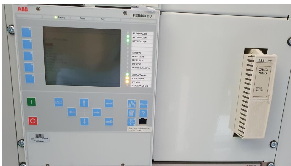
Slika 4: Enota polja zaščite zbiralk ABB REB500 BU s preizkusno vtičnico RTXP18
