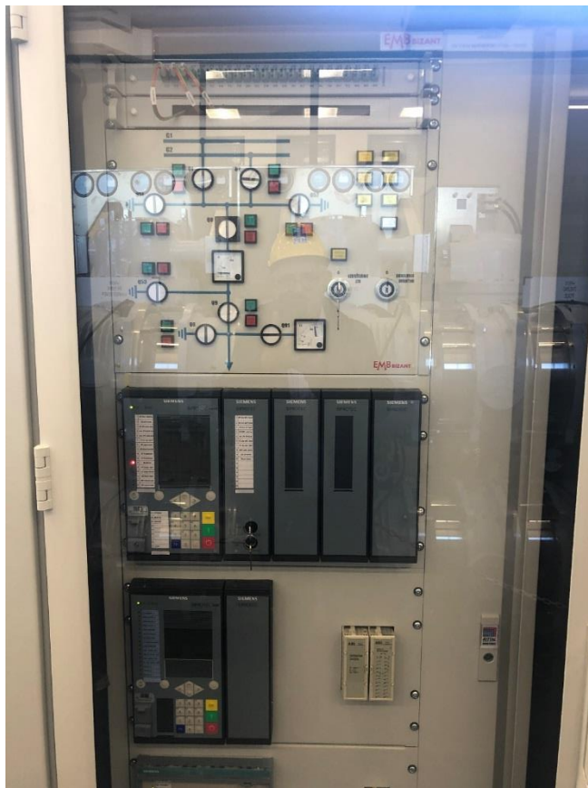
Slika 1: Omara vodenja, zaščite in meritev
