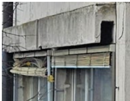
Slika 38: Betonski odkapniki nad okni in zunanje žaluzije
