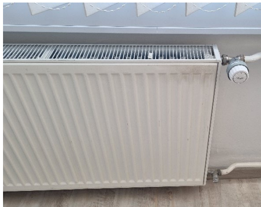
Slika 32: Radiator s termostatskim ventilom
