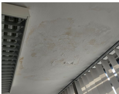
Slika 41: Odstopanje ometa na stropu sejne sobe
