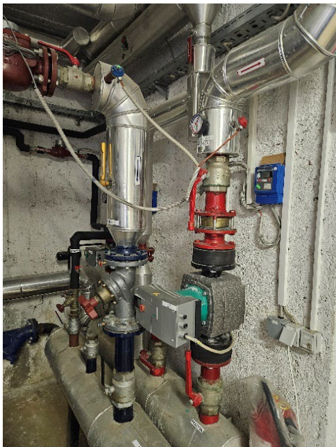
Slika 31: Razvod ogrevalnega sistema
